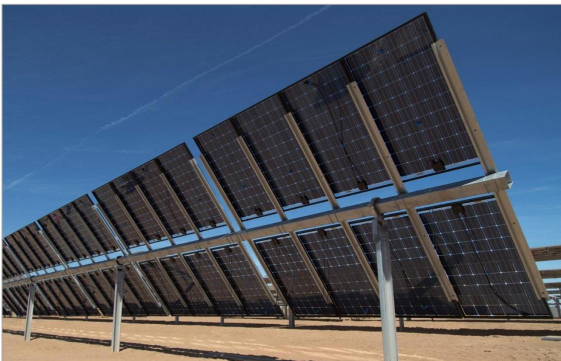
**Figura 3 – Esempio struttura + modulo FV bifacciale**
