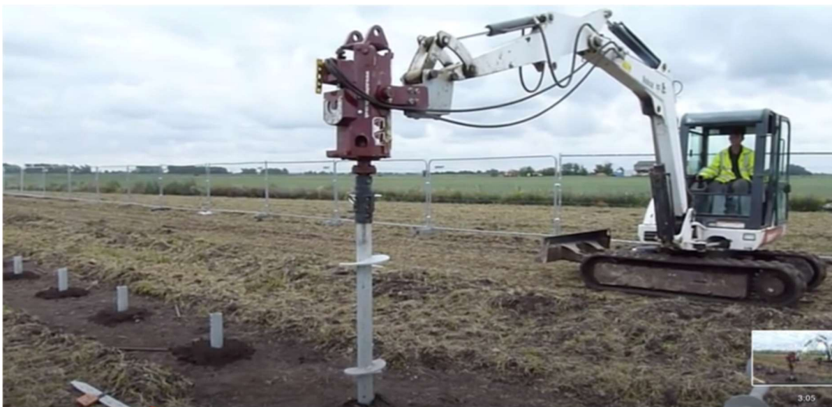
Figura 2-5 Macchina Operatrice per fissaggio supporti strutture
