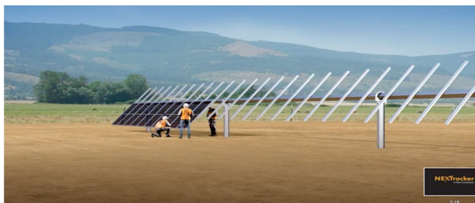
Figura 2-3 Particolare Tracker Horizon-NX Gemin
