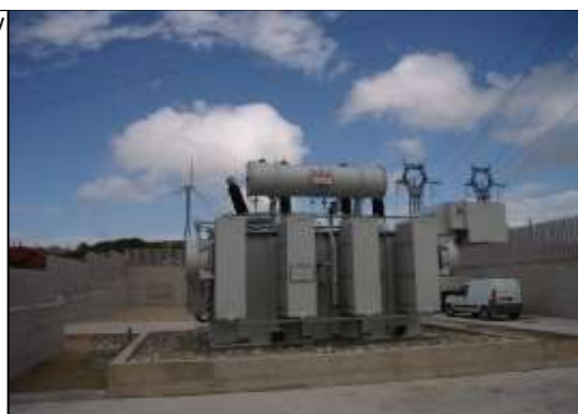
Figura 7-2 Trasformatore MT/AT
