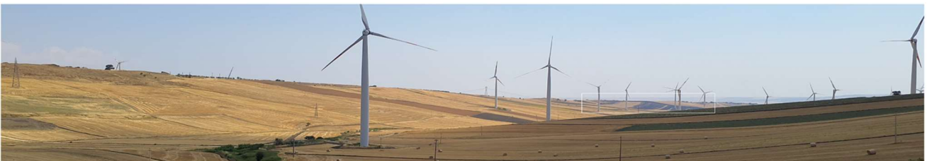
V9- VISTA DALLA STRADA STATALE SR1 IN DIREZIONE EST
