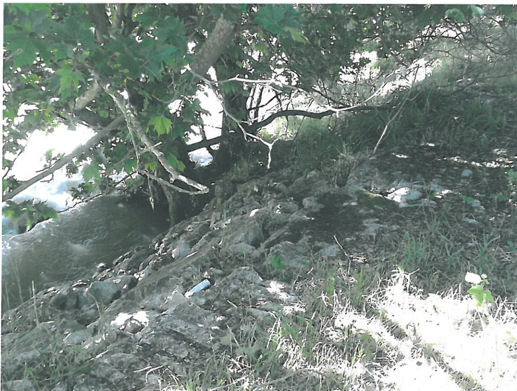
Fotografia 6: Opere di difesa spondale – argine sponda destra
