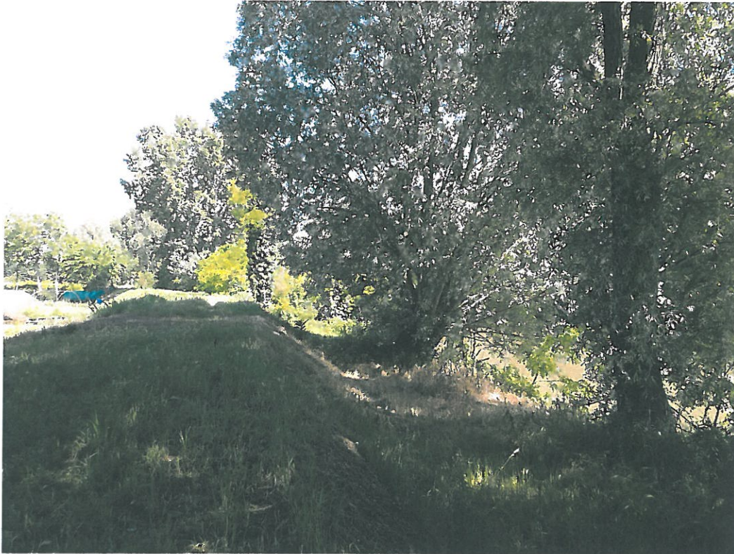
Fotografia 5: Opere di difesa spondale
