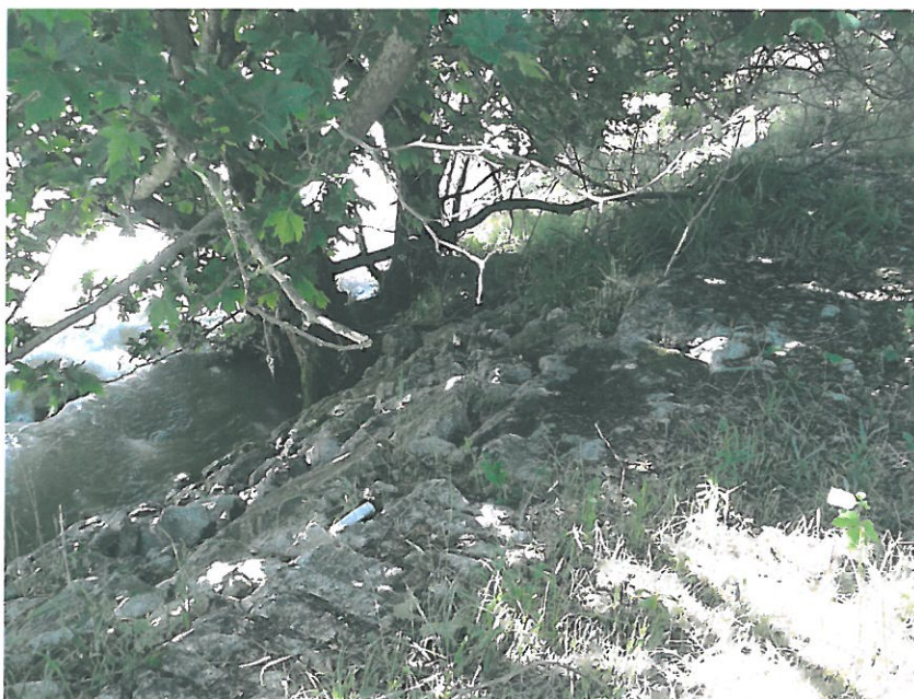
Figura 3.a. Opere di difesa spondale. Scogliera in massi in sponda destra, in prossimità della sezione 45, all'altezza del Km 95 circa dell'asta fluviale.
