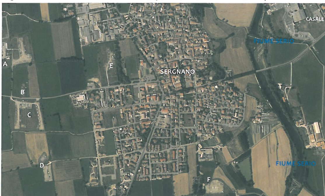
Figura 1.a – Infrastrutture dello stabilimento Stogit di Sergnano (Concessione Sergnano Stoccaggio) – situazione impiantistica 2016 (base: Bing Maps): (A) Centrale – Cluster B; (B) pozzo Sergnano 11; (C) Cluster A e Cluster C; (D) pozzo Sergnano 8; (E) Cluster D; (F) pozzi Sergnano 7/44.
