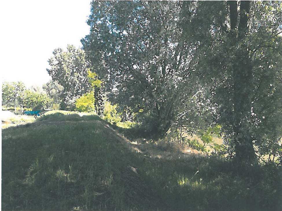
Figura 3.b. Rilevato arginale in prossimità della sezione 45_1.
