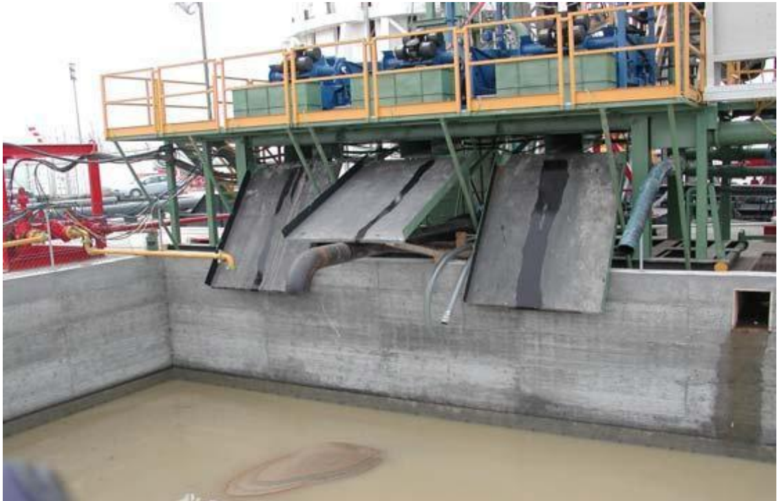
Figura 6-15 Scarto e Raccolta Detriti e Fango di Perforazione
