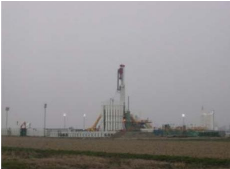
Figura 6-2 Vista Impianto di Perforazione HH220
