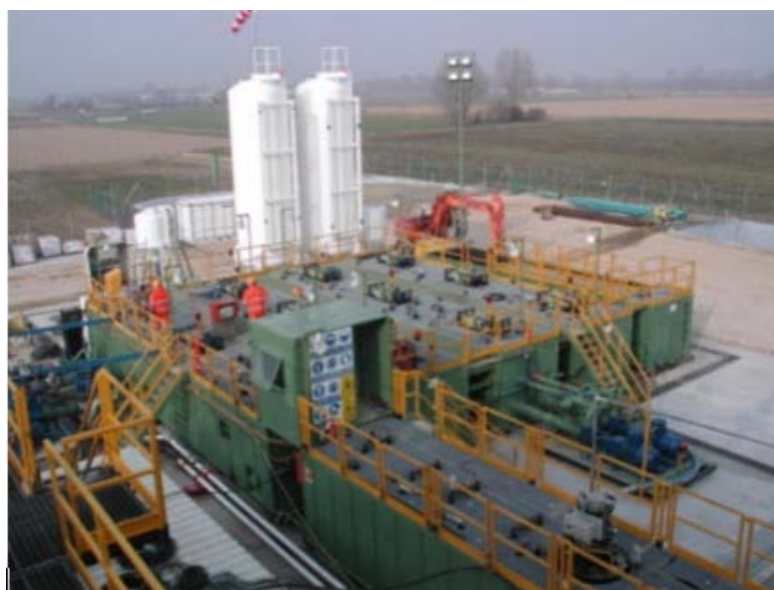
Figura 3-36 Impianto di perforazione HH220: circuito fango
