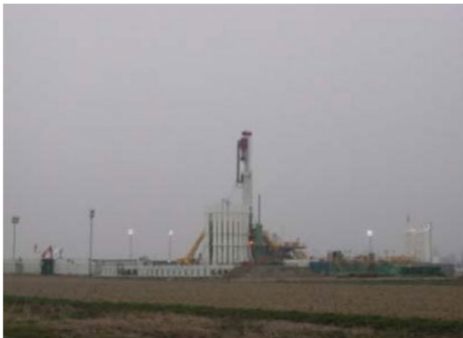
Figura 3.8 Vista Impianto di Perforazione HH220
