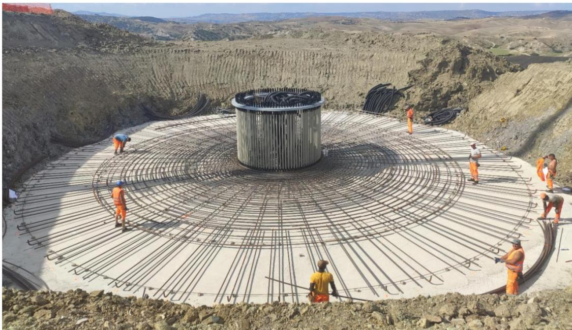
**Figura 5-3: immagine tipo posa anchor cages**
