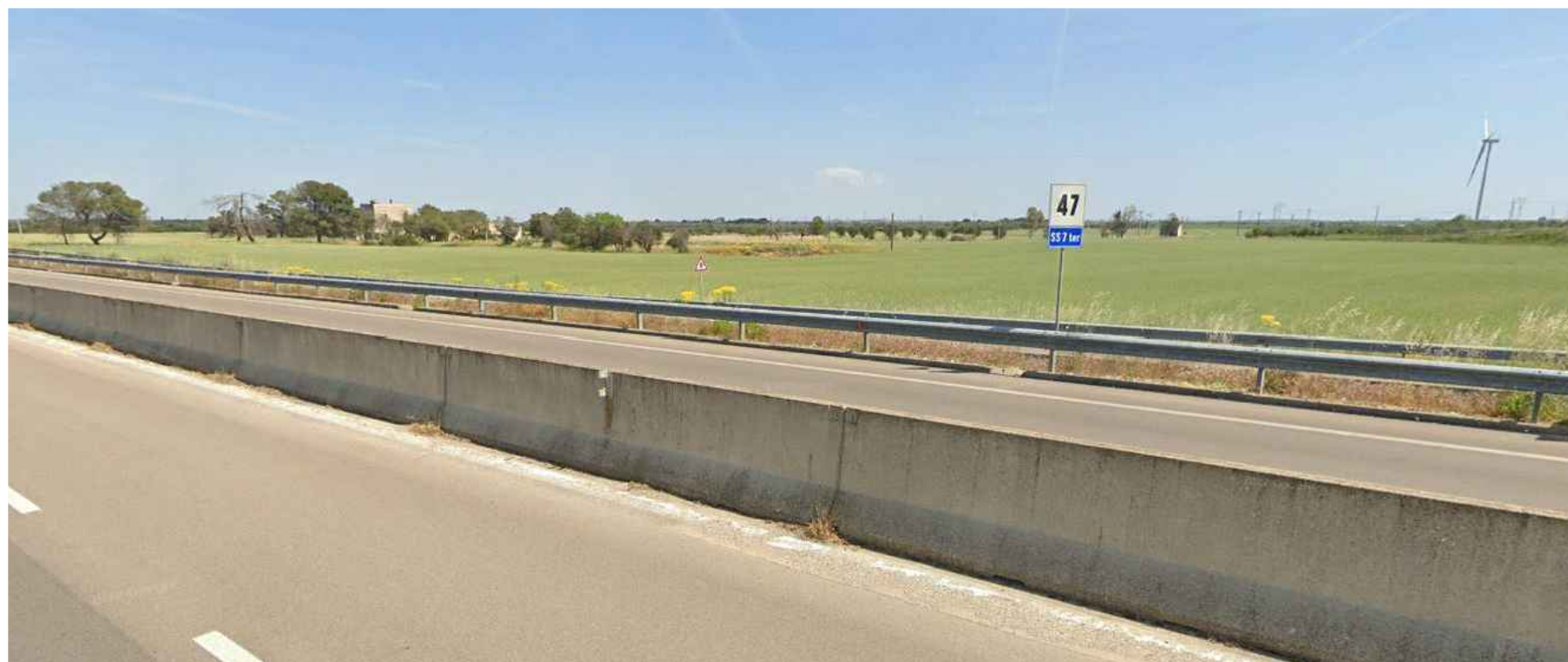
PUNTI DI VISTA n.9 - SS7ter Strada a valenza Paesaggistica nei pressi della Masseria L'Argentone (Sant'Angelo) (MSD42201), Erchie - ante operam
