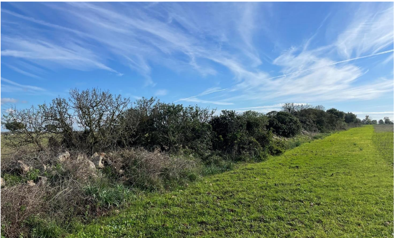
Foto 20 Muretto a secco in stato di abbandono
