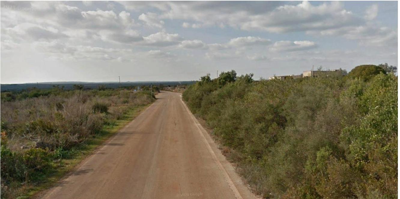
Figura 5-3: Viabilità SP219 nei pressi della WTG3
