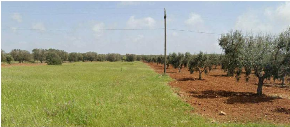
PUNTI DI VISTA n.8 - SP143, Regio Tratturo Martinese n. 73 nei pressi della Masseria Monte la Conca (MSA51404) e della Masseria Bosco (TA000875), Avetrana - ante operam
