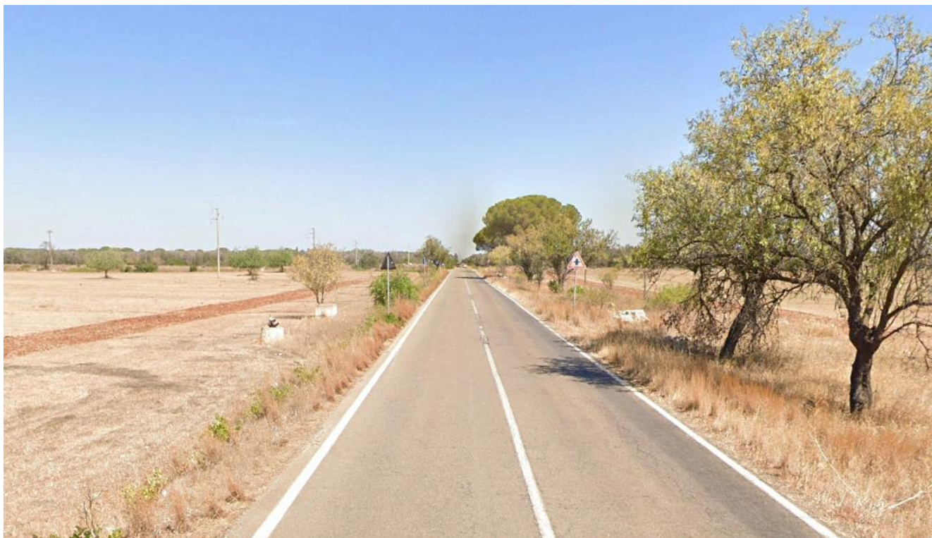
Figura 5-2: Viabilità SP109 nei pressi della WTG4
