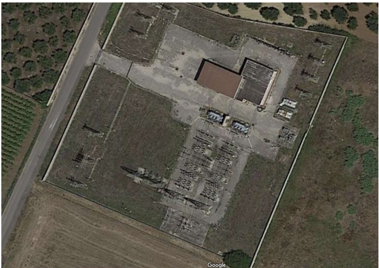
CP Mesagne: Cabina Primaria esistente (attuale configurazione)
