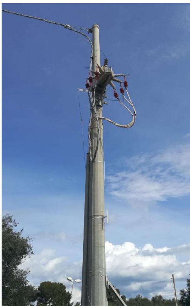
**Particolare di sostegno poligonale in lamiera
