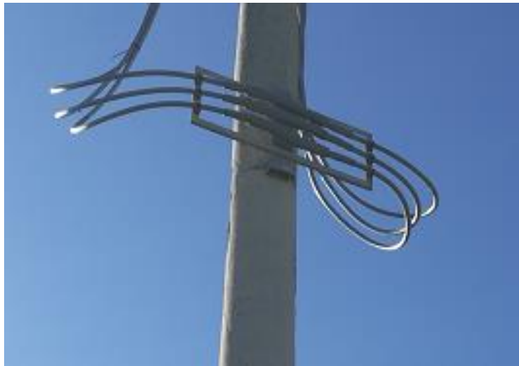
Particolare di giunzione aerea
