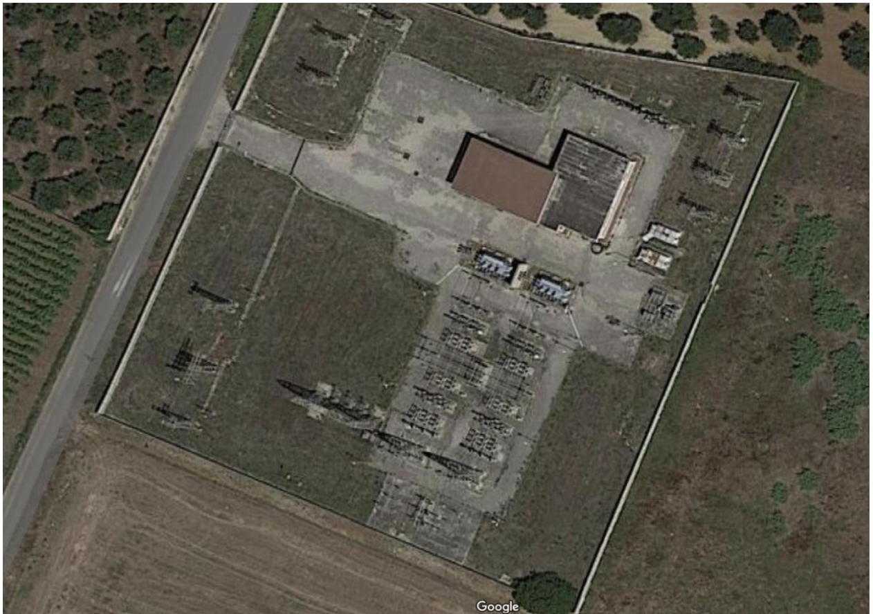
CP Mesagne: Cabina Primaria esistente (attuale configurazione)
