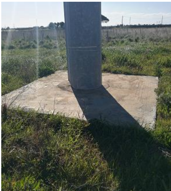
Particolare di fondazione monolitica affiorante
