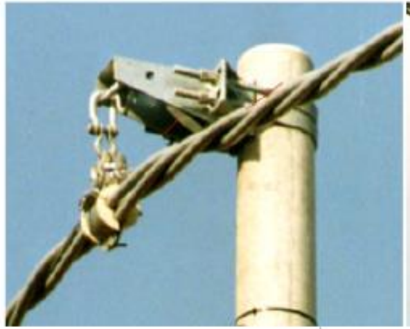
Particolare di morsa per sospensione e relativo amarro
