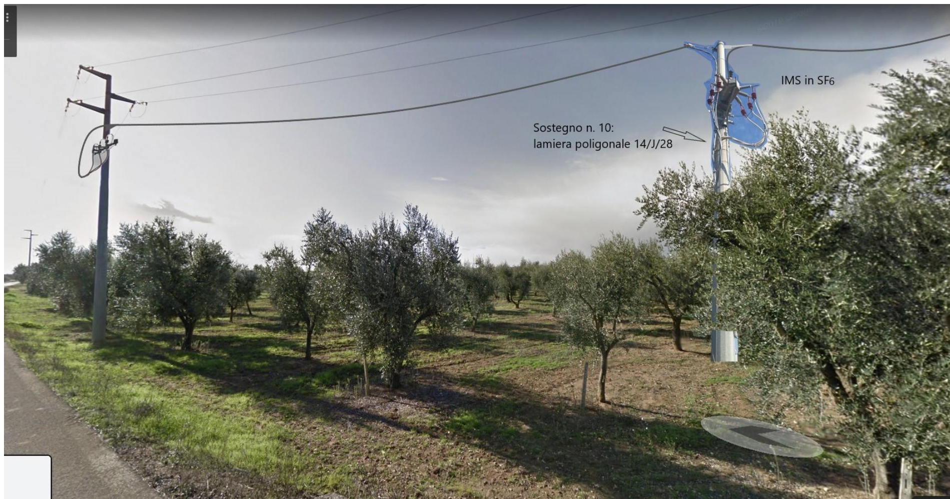
Rappresentazione fotografica della "Richiusura" su "MT GUIDONE" con IMS
