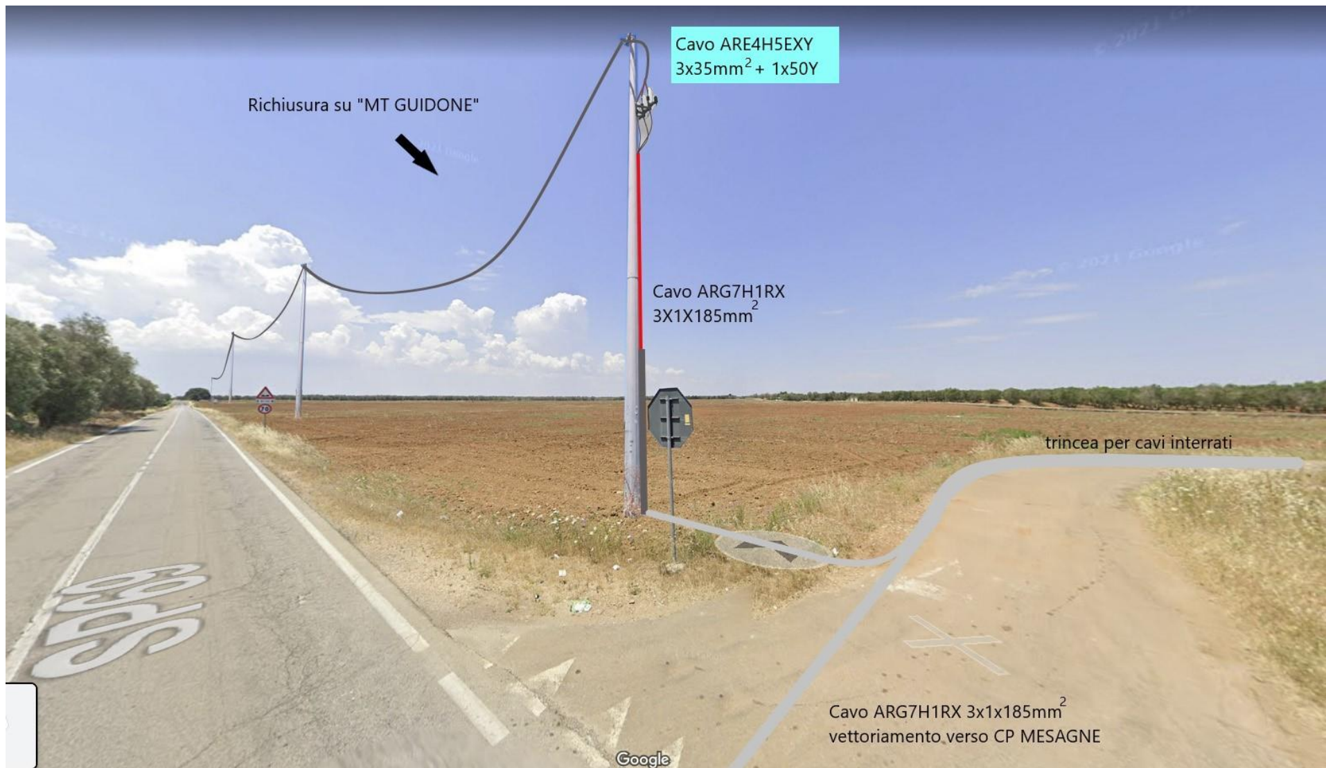
Rappresentazione fotografica della partenza linea aerea per "Richiusura" su "MT GUIDONE"
