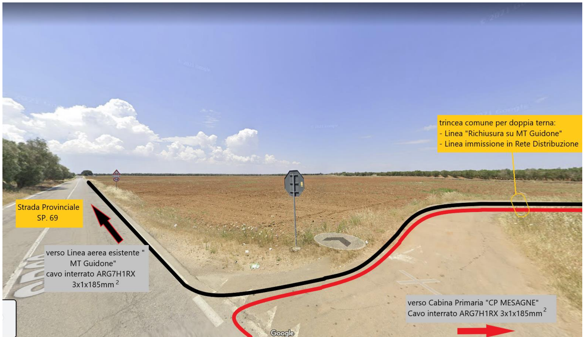
Rappresentazione fotografica della diramazione per "Richiusura" su "MT GUIDONE" ed immissione in Rete Distribuzione
