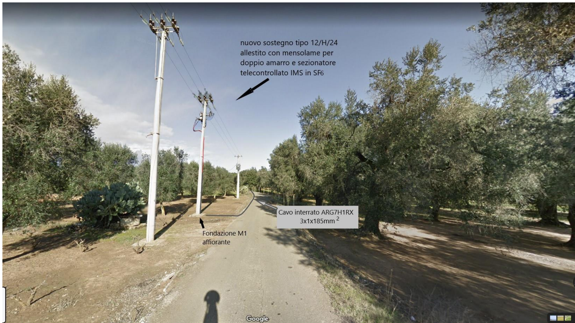
Rappresentazione fotografica della immissione su linea aerea esistente "MT Guidone" con IMS in SF 6
