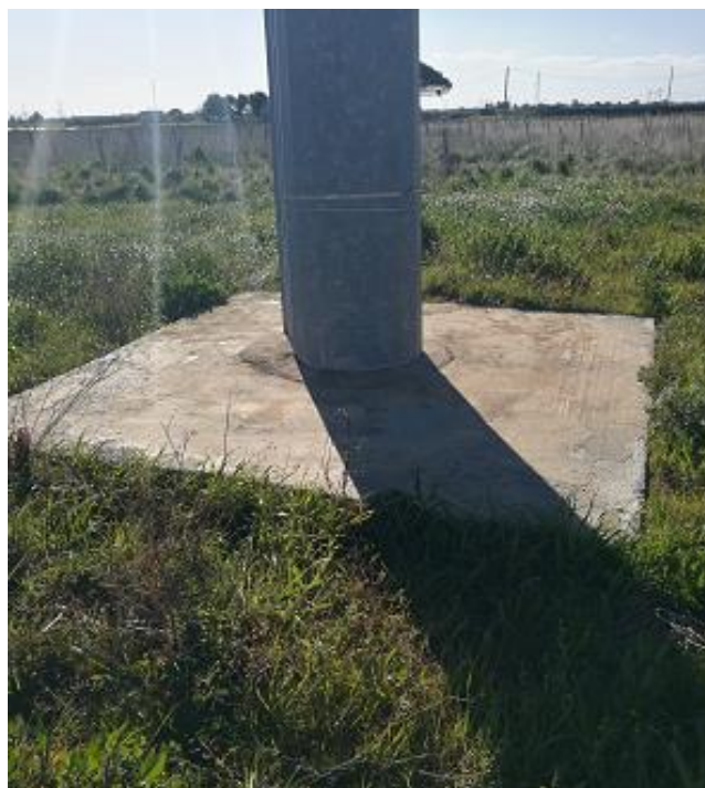
Particolare di fondazione monolitica affiorante
