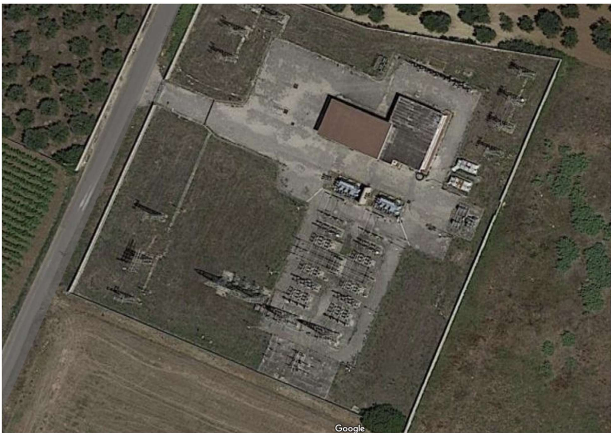
CP Mesagne Ante-opera: Cabina Primaria esistente (in attuale configurazione)
