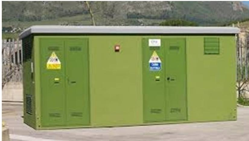
*Figura 2 Cabina prefabbricata tipica utilizzata in progetto*
