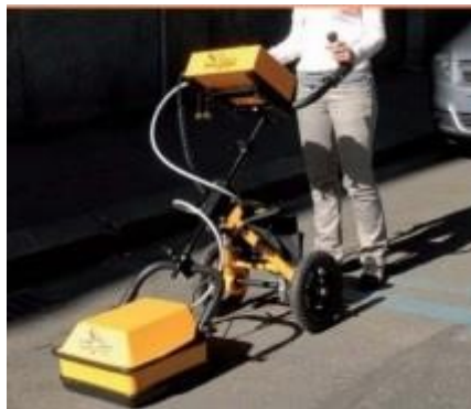
Figura 32 Verifica presenza sottoservizi con georadar
