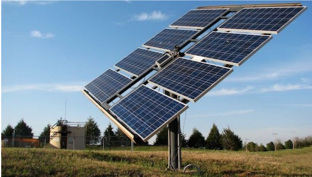
Figura 41 - Inseguitori monoassiali di "azimut"
