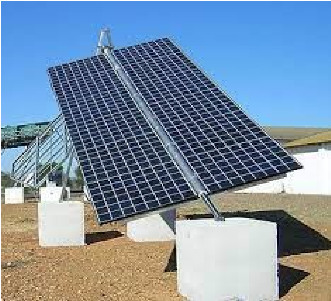
Figura 5 - Inseguitori monoassiali ad "asse polare"
