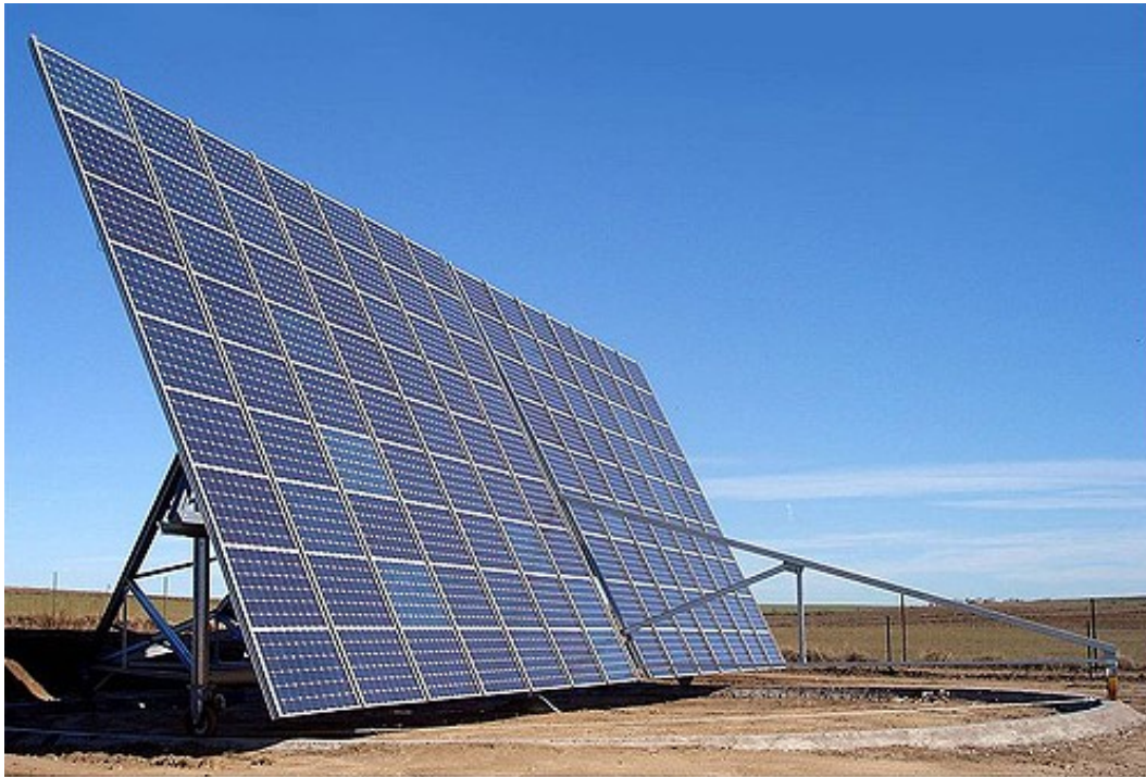
Figura 7 - Inseguitore biassiale "tilt – rollio"
