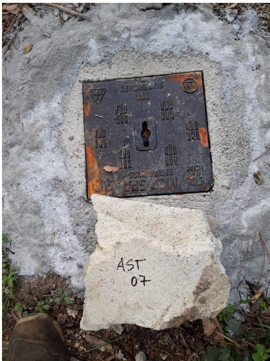
FIGURA N. 19 - Piezometro AST_07
