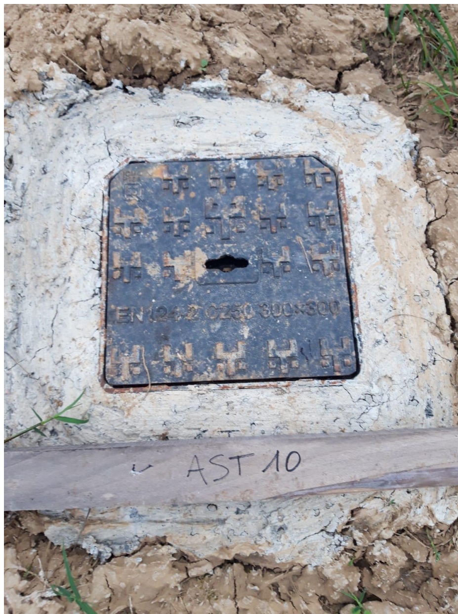
FIGURA N. 22 - Piezometro AST_10
