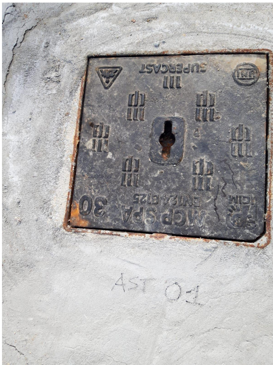
FIGURA N. 13 - Piezometro AST_01
