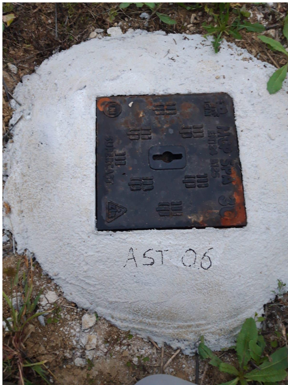
FIGURA N. 18 - Piezometro AST_06
