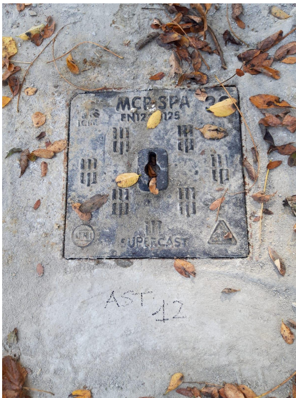
FIGURA N. 24 - Piezometro AST_12
