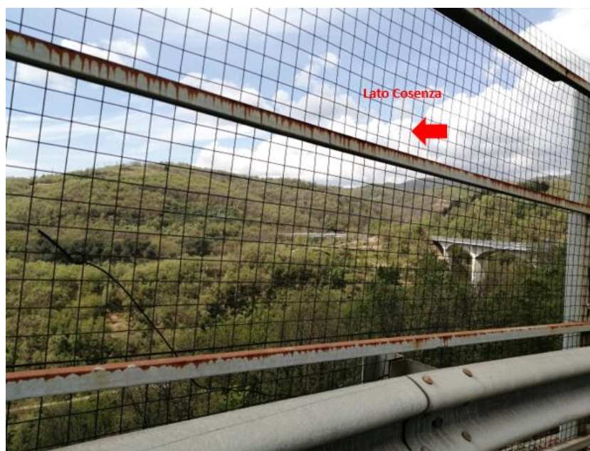
Figura 166 -Particolare del punto di vista 1
