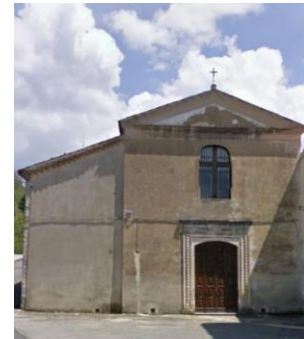
Figura 49 – Chiesa della Riforma (Estratto dal sito http://vincoliinrete.beniculturali.it/vir/vir/vir.html )
