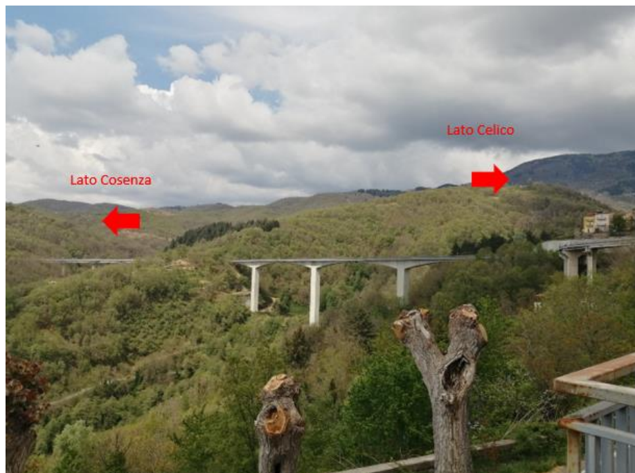
Figura 168 -Particolare del punto di vista 3
