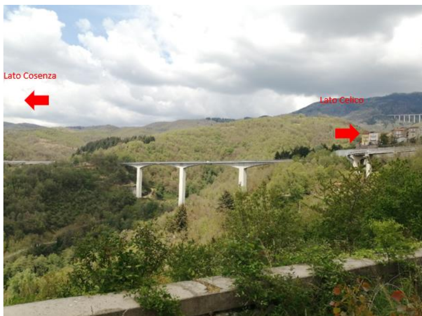
Figura 167 -Particolare del punto di vista 2
