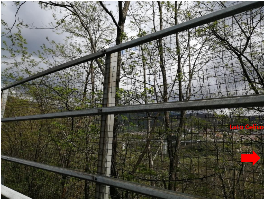
Figura 170 -Particolare del punto di vista 5
