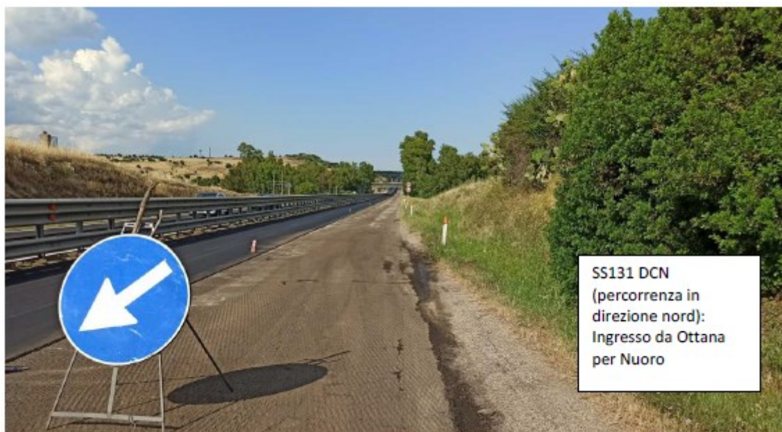
Fig. 5 – Ripresa fotografica della SS131 Ingresso nord da Ottana per Nuoro (Fonte: Allegato N alla Lista di Controllo - Quaderno Fotografico Intervento A)
