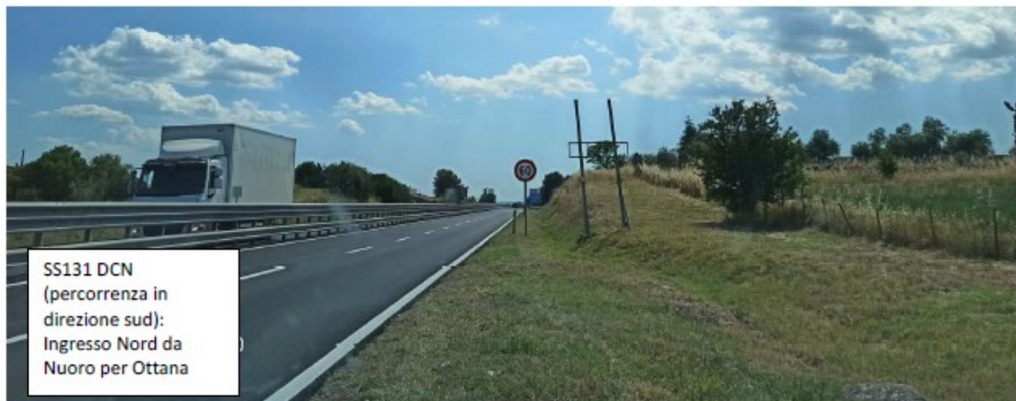
Fig. 4 - Ripresa fotografica della SS131 Ingresso nord da Nuoro per Ottana (Fonte: Allegato N alla Lista di Controllo - Quaderno Fotografico Intervento A)
