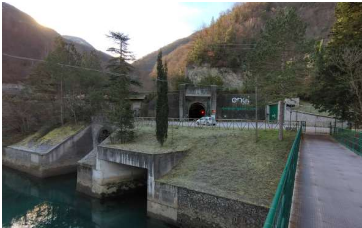
Figura 5: Vista dell'imbocco della galleria di accesso alla Centrale di San Giacomo lungo il corso del Fiume Vomano
