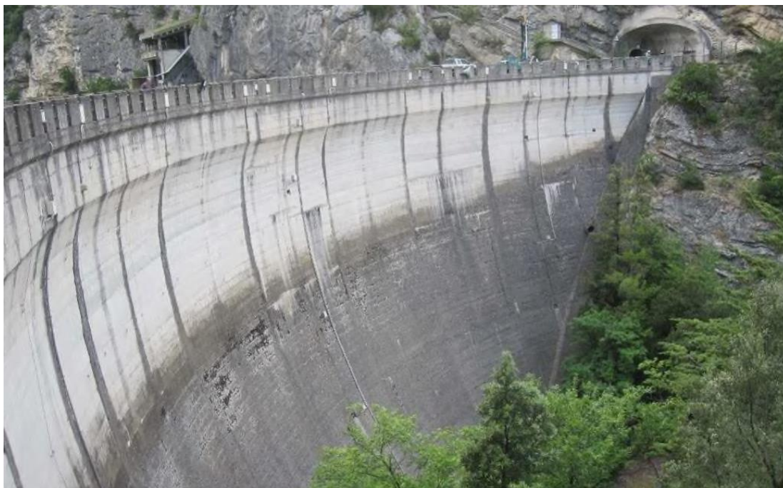
Figura 5: Diga di Piaganini – Vista da valle
