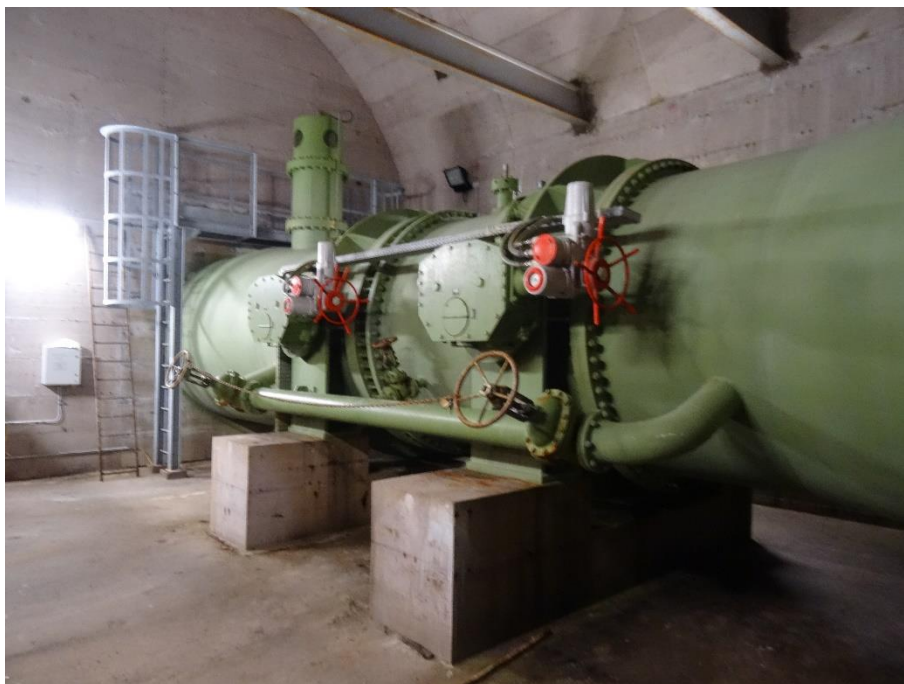
Figura 10: San Giacomo II – restituzione –camera valvole dell’esistente gruppo reversibile
