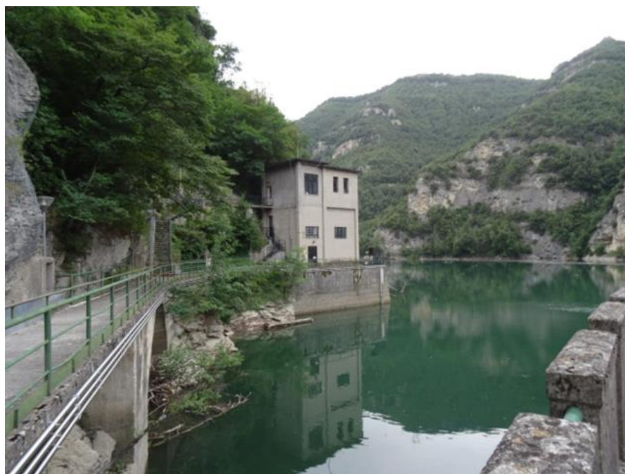
Figura 6: Diga di Piaganini – Vista su opera di presa Montorio e paramento di monte
