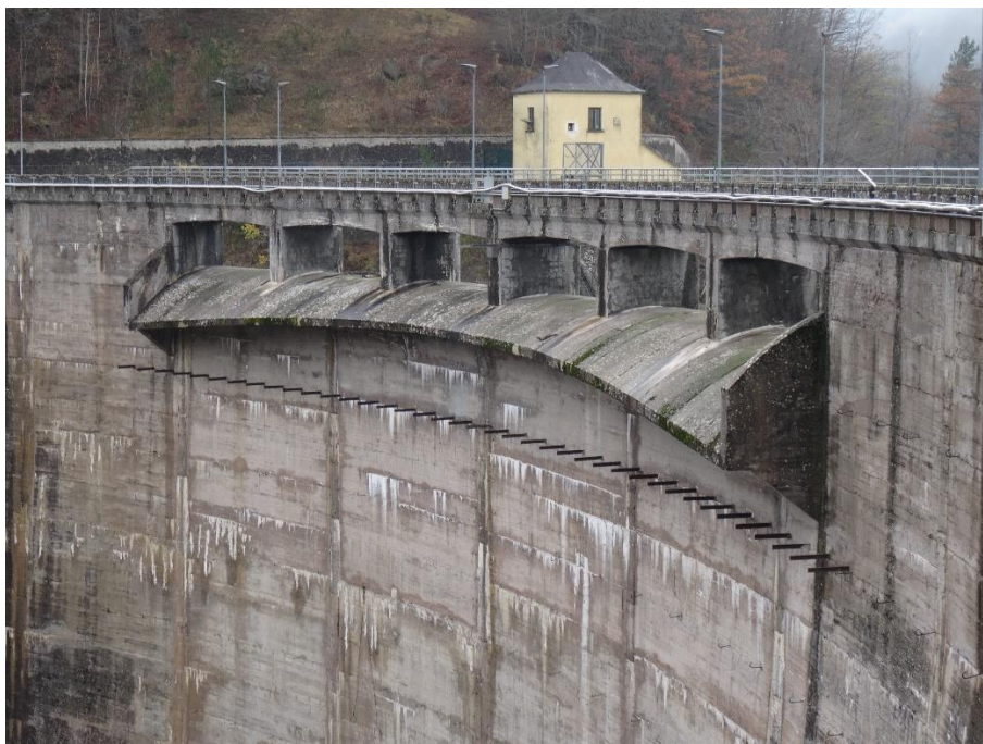
Figura 3: Diga di Provvidenza – Scarico di superficie
