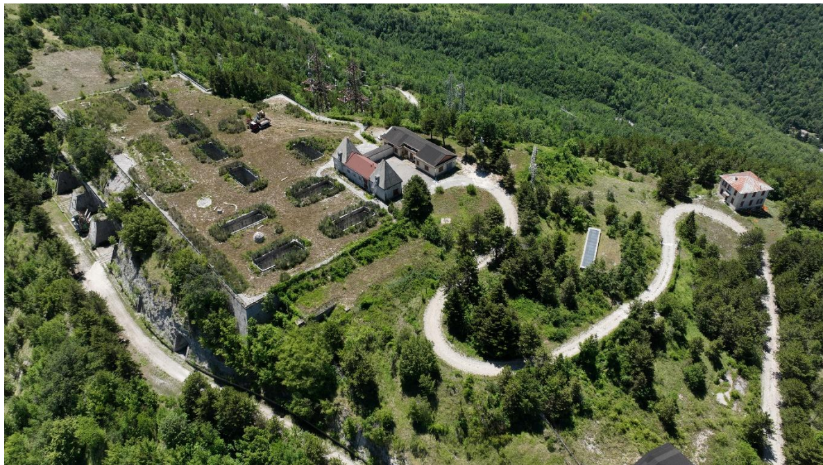
Figura 8: San Giacomo II – zona PP Monte – vista aerea su pozzo e vecchia sottostazione
