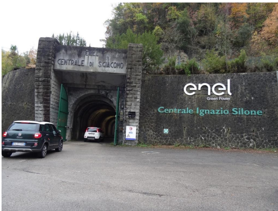
Figura 12: C.le San Giacomo - esterni – vista sulla galleria d'accesso
