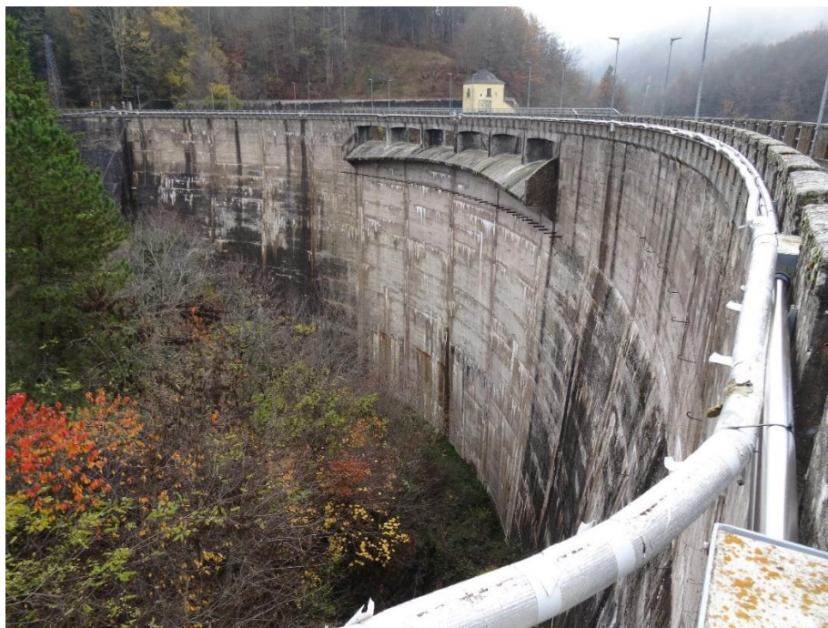
Figura 1: Diga del Provvidenza – Vista da valle
