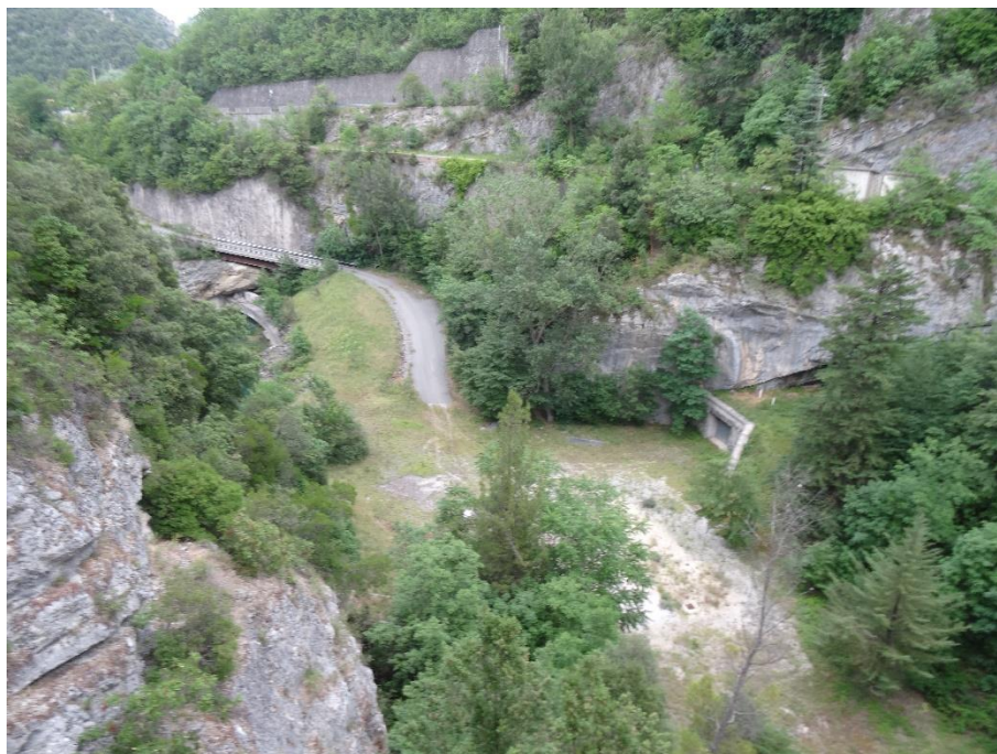
Figura 9: San Giacomo II – restituzione – finestra di accesso alla camera valvole dell'esistente gruppo reversibile
