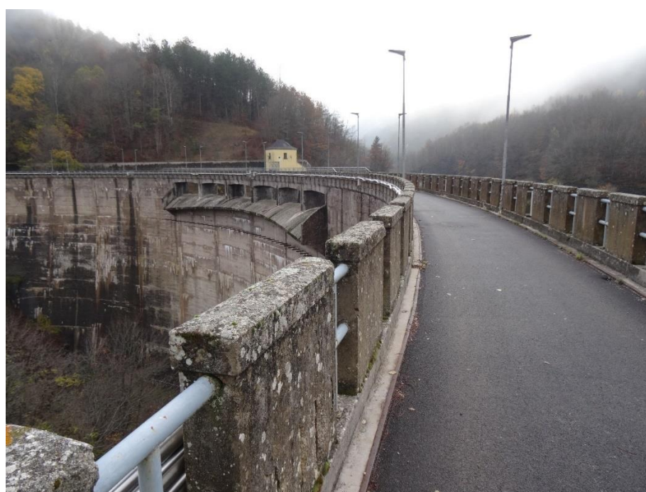
Figura 2: Diga di Provvidenza – piano di coronamento
