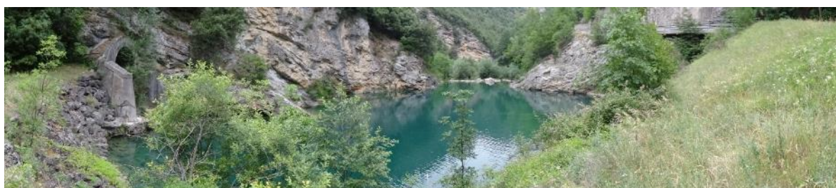
Figura 14: Vista dell'organo di scarico della diga di Piaganini
