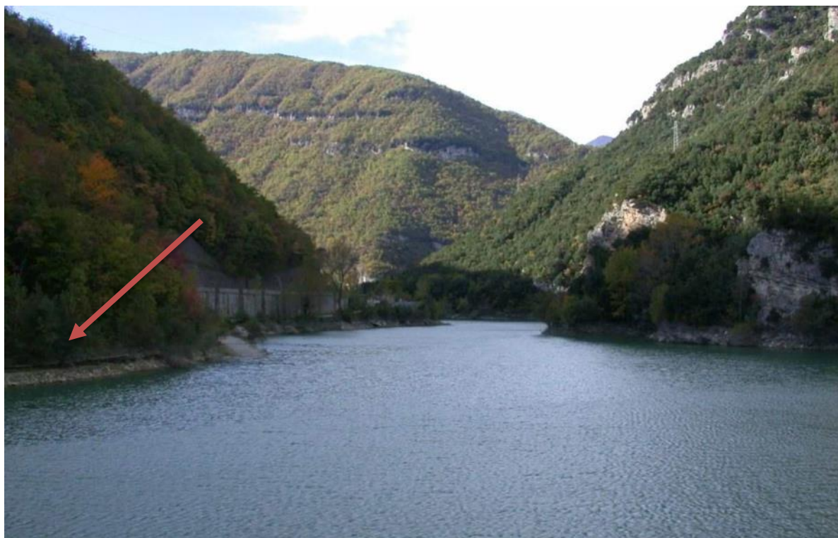
Figura 6: Invaso di Piaganini visto dalla diga
