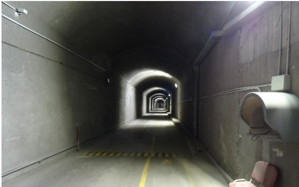
Figura 9: Galleria carrabile di accesso alla caverna di S. Giacomo
