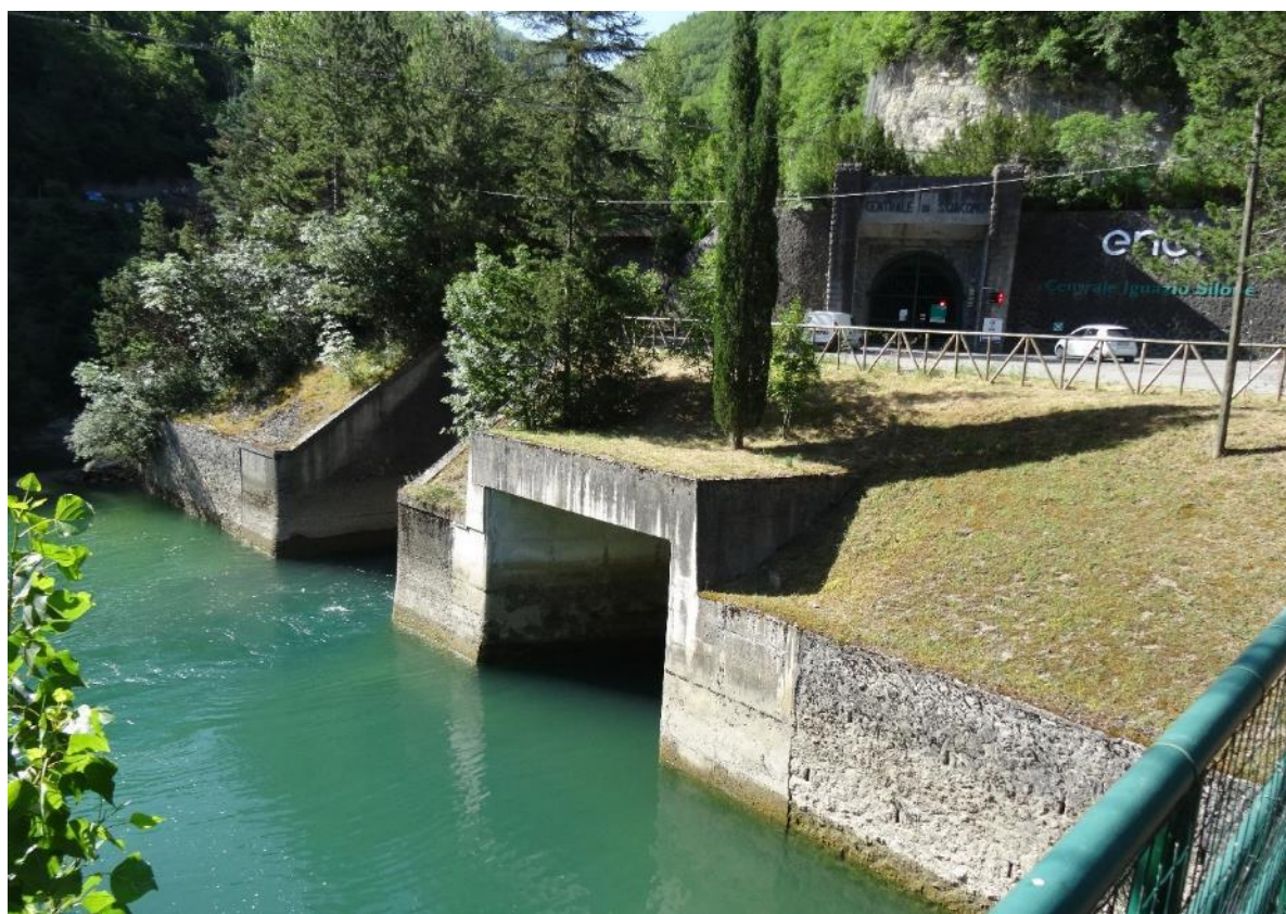
Figura 8: Piazzale di accesso alla centrale di S. Giacomo e scarico nell'invaso di Piaganini
