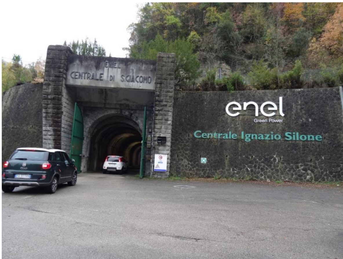
Figura 18: Piazzale di ingresso all'esistente centrale di San Giacomo
