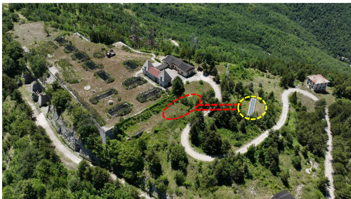
Figura 16: Vista da drone: area di intervento per adeguamento pozzo piezometrico (nuove opere in rosso)
