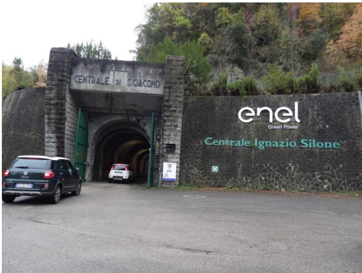
Figura 2: Piazzale di ingresso all'esistente centrale di San Giacomo
