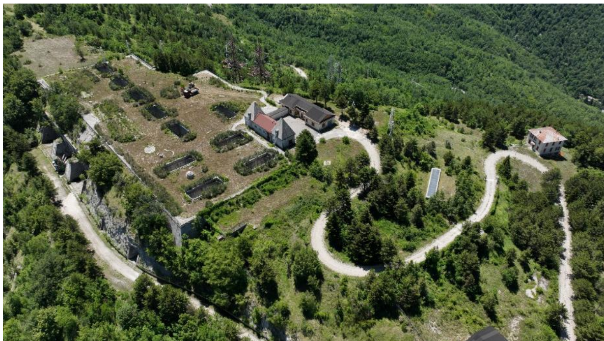
Figura 3: Vista dal drone dell'area di intervento per adeguamento del pozzo piezometrico
