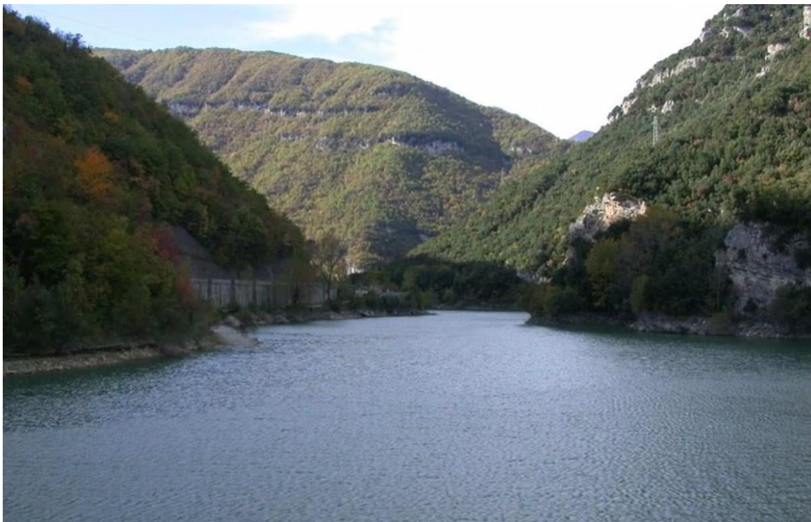
Figura 16: Serbatoio di Piaganini – vista aerea
