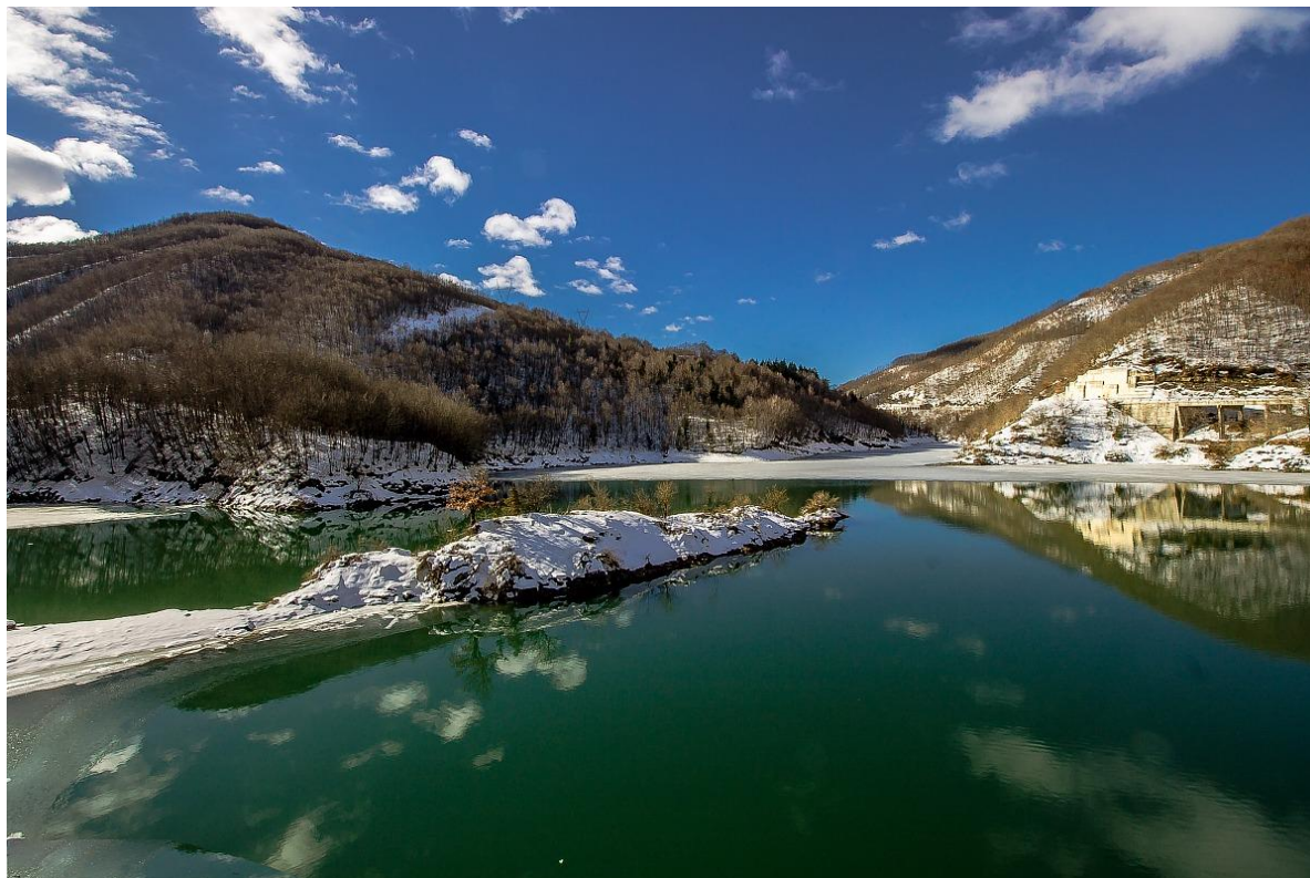
Figura 9: Serbatoio di Provvidenza
