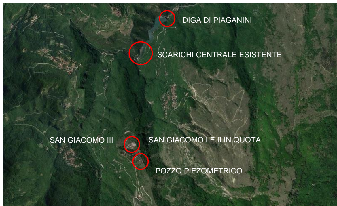
Figura 3: Inquadramento generale impianto San Giacomo
