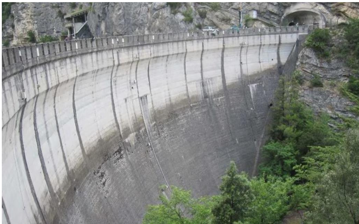
Figura 17: Diga di Piaganini - vista da valle
