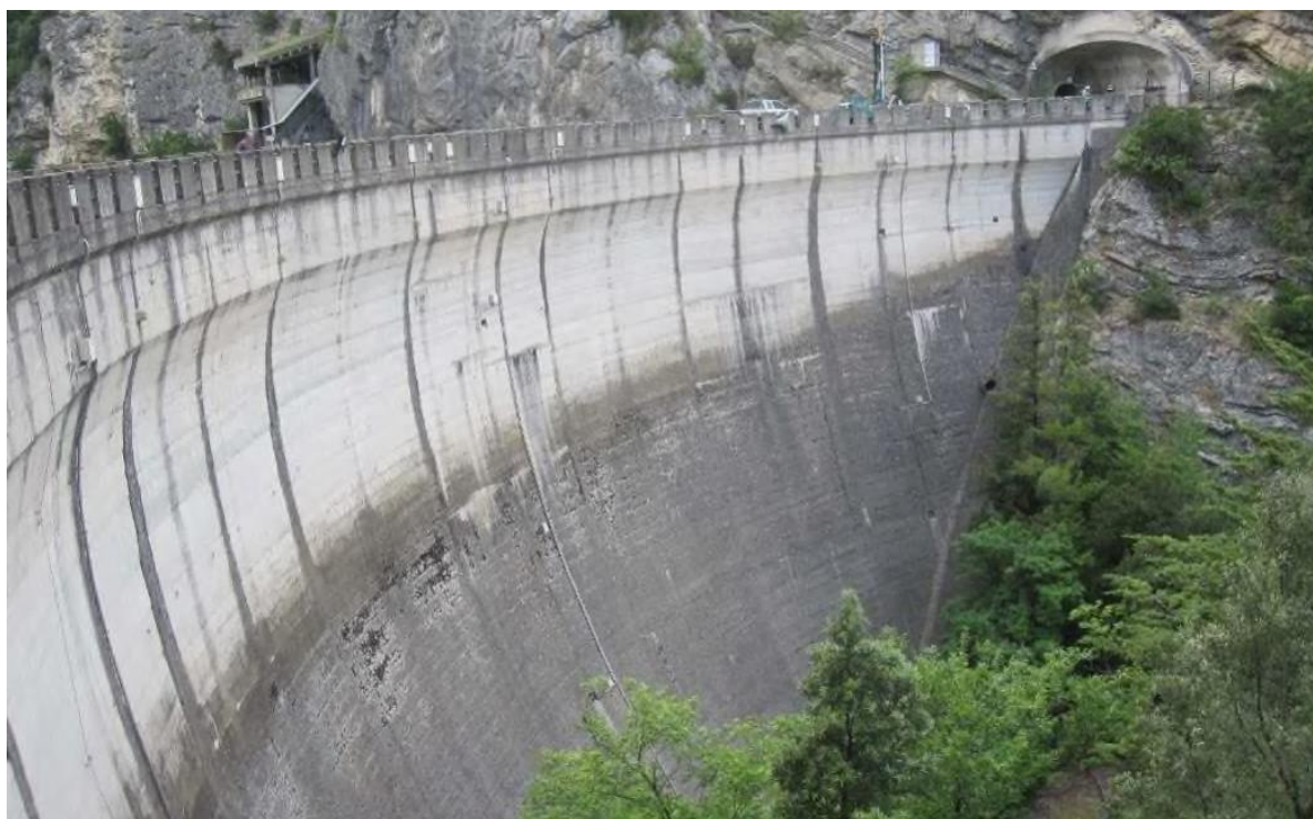
Figura 8: Diga di Piaganini – vista da valle
