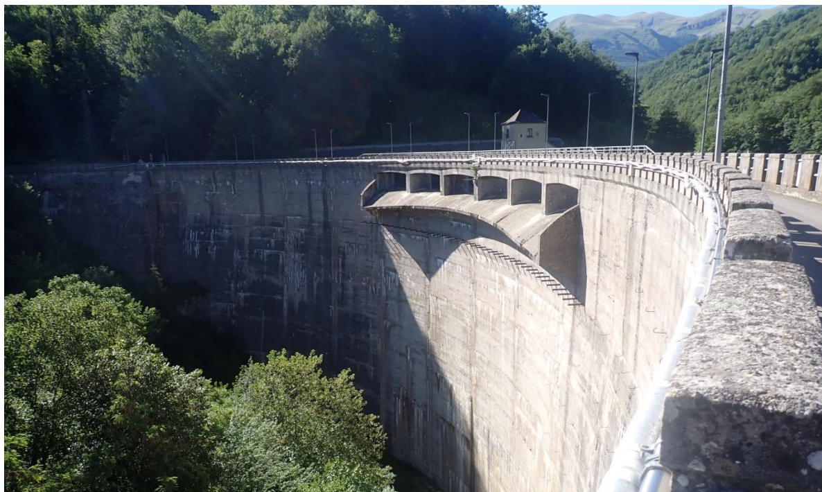
Figura 5: Diga di Provvidenza – vista da valle
