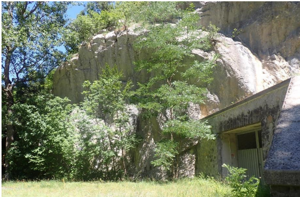
Figura 23: Particolare del portale di accesso a valle della diga con alcune robinie ai piedi del basamento roccioso
