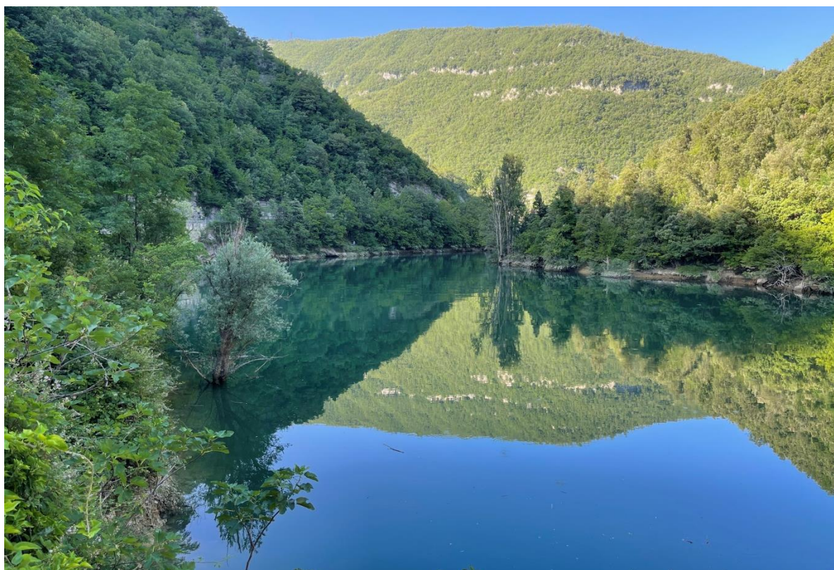
Figura 9: Serbatoio di Piaganini
