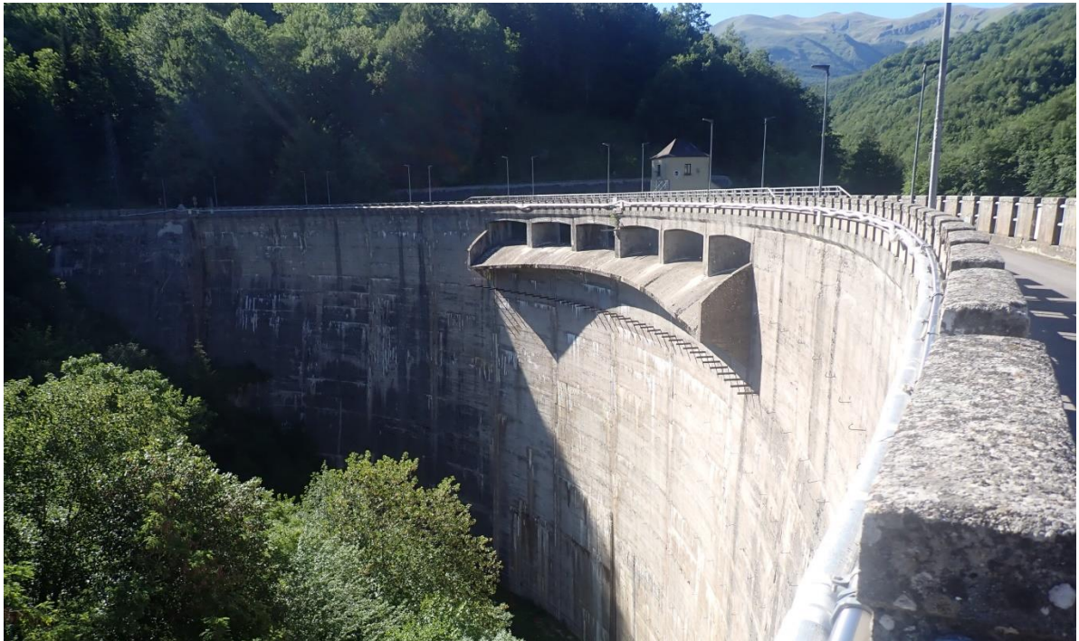
Figura 8: Diga di Provvidenza – vista da valle
