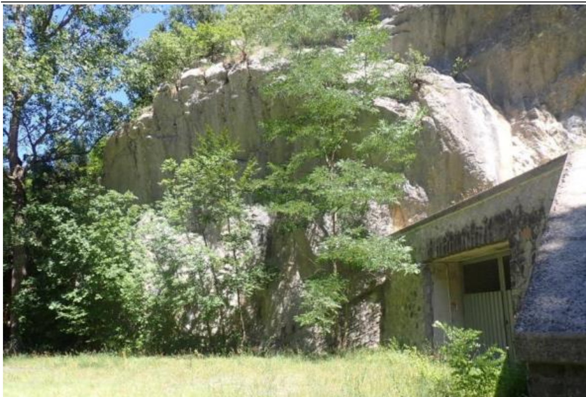
Figura 103: Foto stato di fatto – opera di presa
