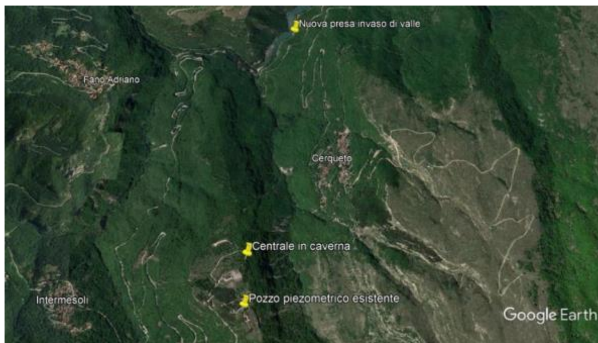
Figura 53: Zone di intervento previste; le aree di cantiere sono concentrate negli ambiti indicati
