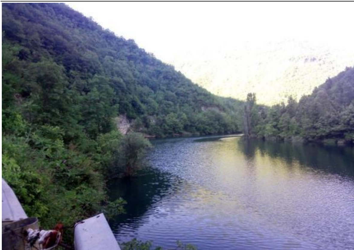
Figura 107: Foto stato di fatto – opera di presa
