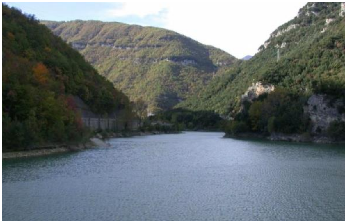
Figura 16: Serbatoio di Piaganini – vista aerea
