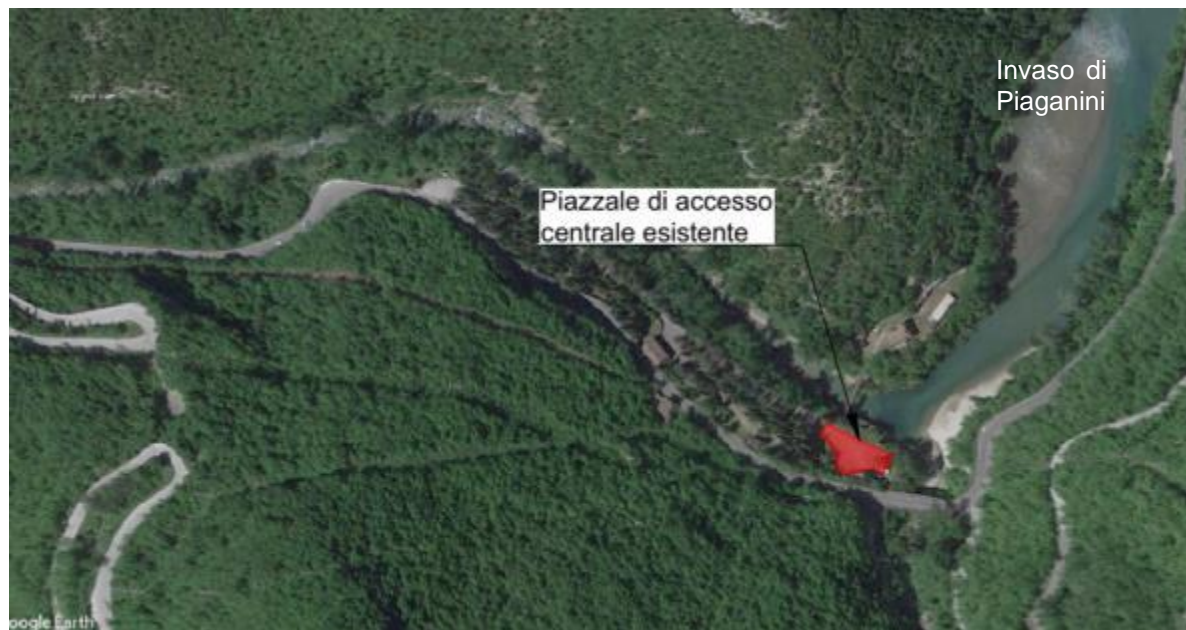
Figura 94: Inquadramento cantiere “bacino di valle”
