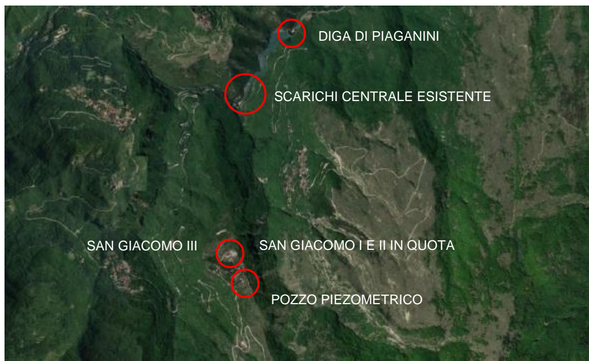
Figura 3: Inquadramento generale impianto San Giacomo
