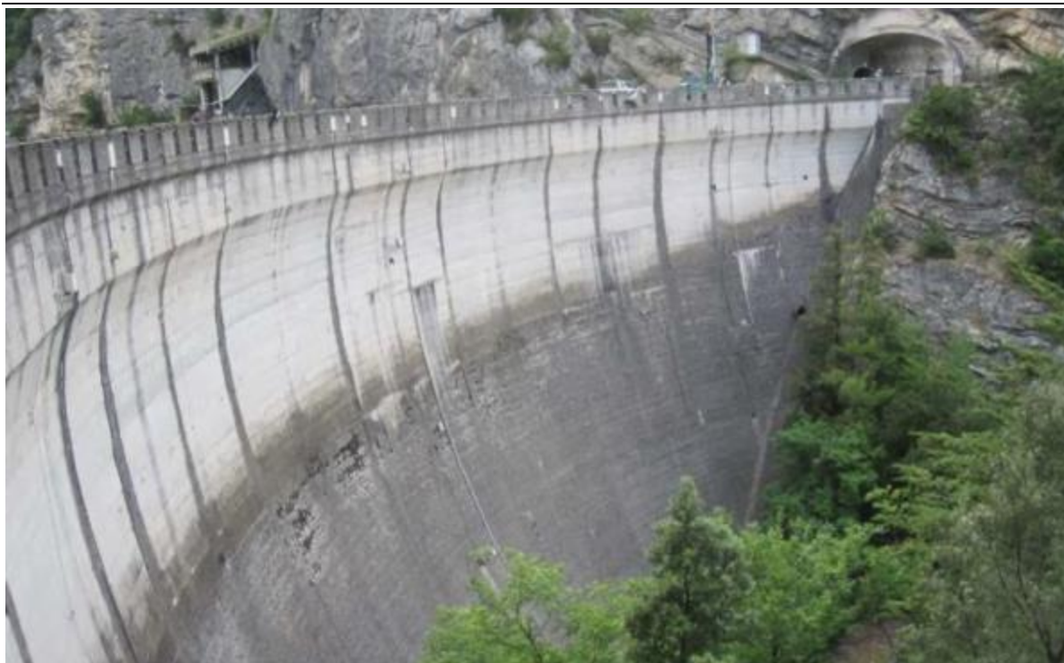
Figura 17: Diga di Piaganini - vista da valle
