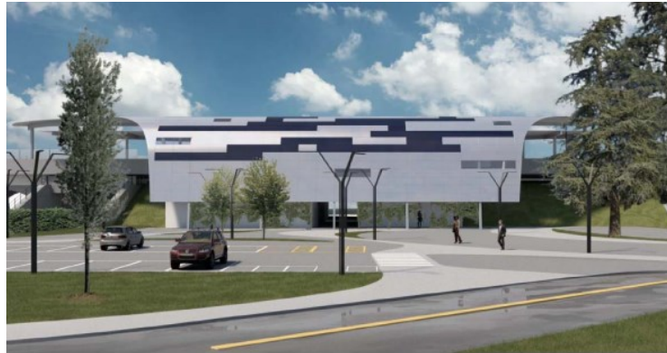
Figura 11: vista prospetto Sud-Est da via Garfagnana
