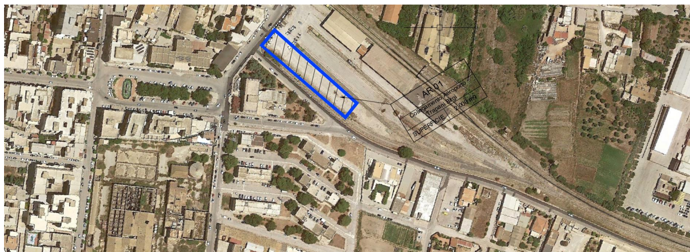
Area di stoccaggio materiali di armamento nella stazione di Marsala
