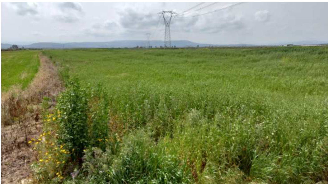
Foto area Sottostazione di utenza MAAS 2
