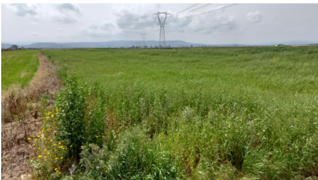
Foto area Sottostazione di utenza MAAS 2
