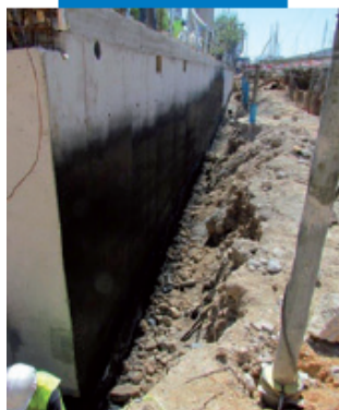
Muro di fondazione impermeabilizzato con Plastimul 2K Reactive
