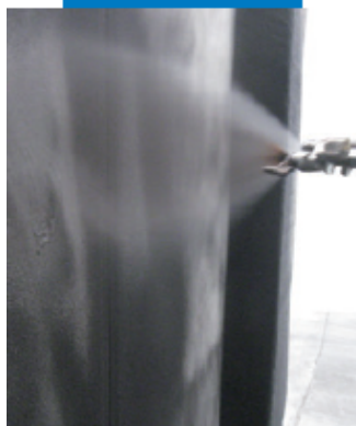
Fase di applicazione di Plastimul 2K Reactive
