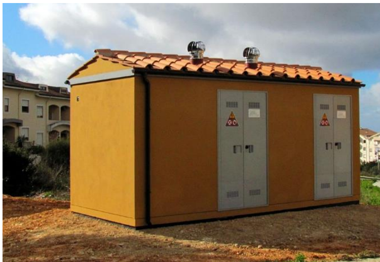
Figura 31 - Immagine di una cabina di consegna specifica DG2092 Rev.03 del 15/09/2016
