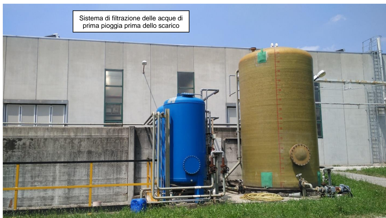
Figura 6-8. Vasca di prima pioggia – Sistema di filtrazione finale prima dello scarico
