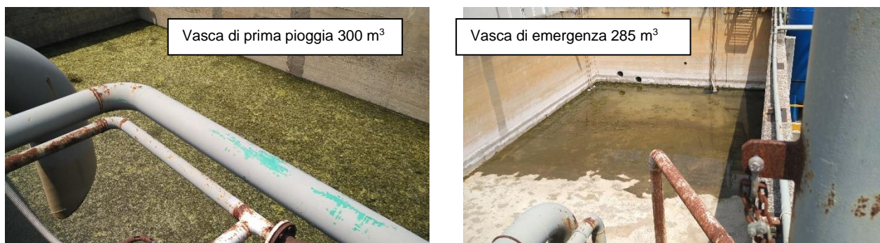
Figura 6-6. Vasca di prima pioggia e ulteriore vasca di emergenza
