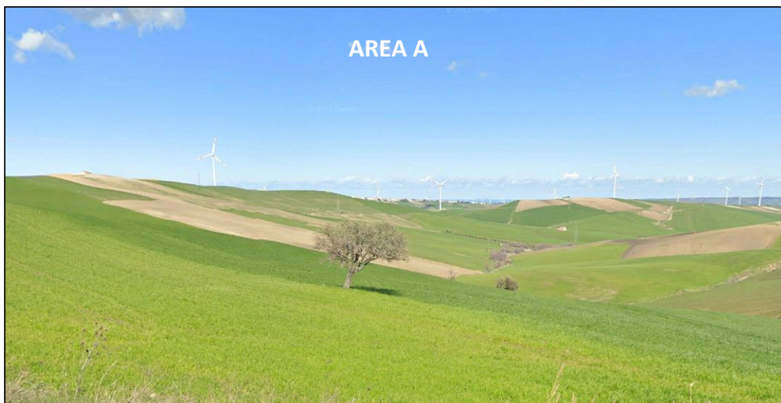
Figura 14 – Area A impianto FTV vista da OVEST
