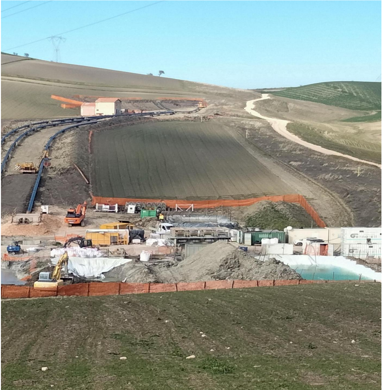
Fig 9 Tratturo S. Andrea - Biferno e lavorazioni in corso per il metanodotto a limite dell'area interessata dal progetto dell'impianto fotovoltaico
