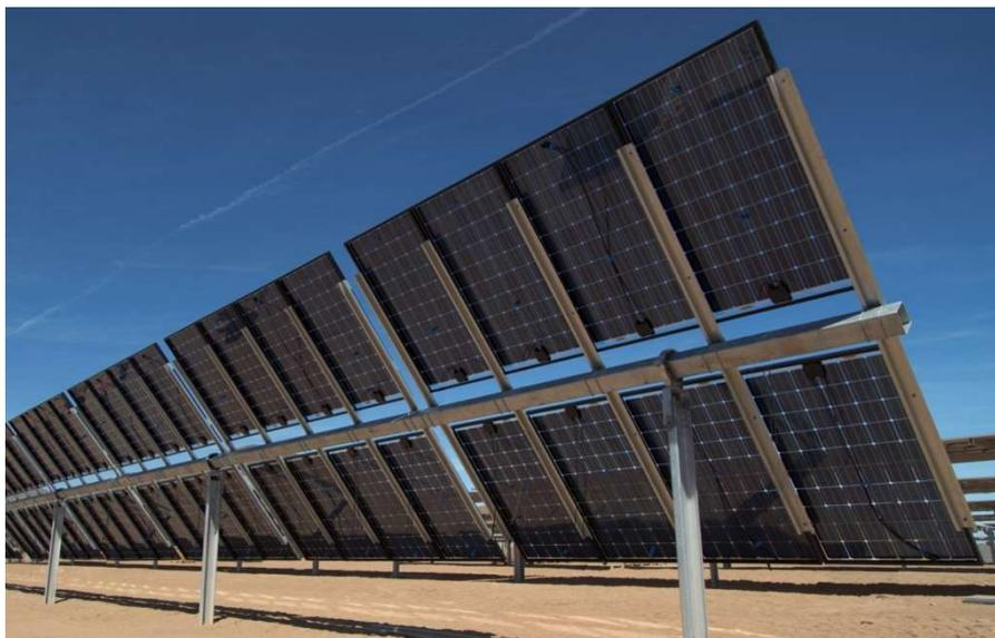
*Figura 5-2 – Esempio di struttura + modulo FV bifacciale*
