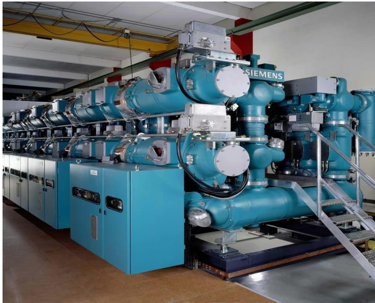
Figura 17 - Celle AT 220kV in stazione Off-shore (fonte Siemens)
