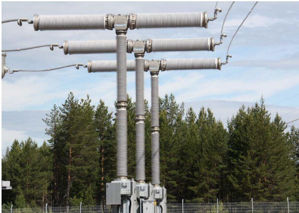
Figura 29 - interruttore 420kV (fonte Siemens)
