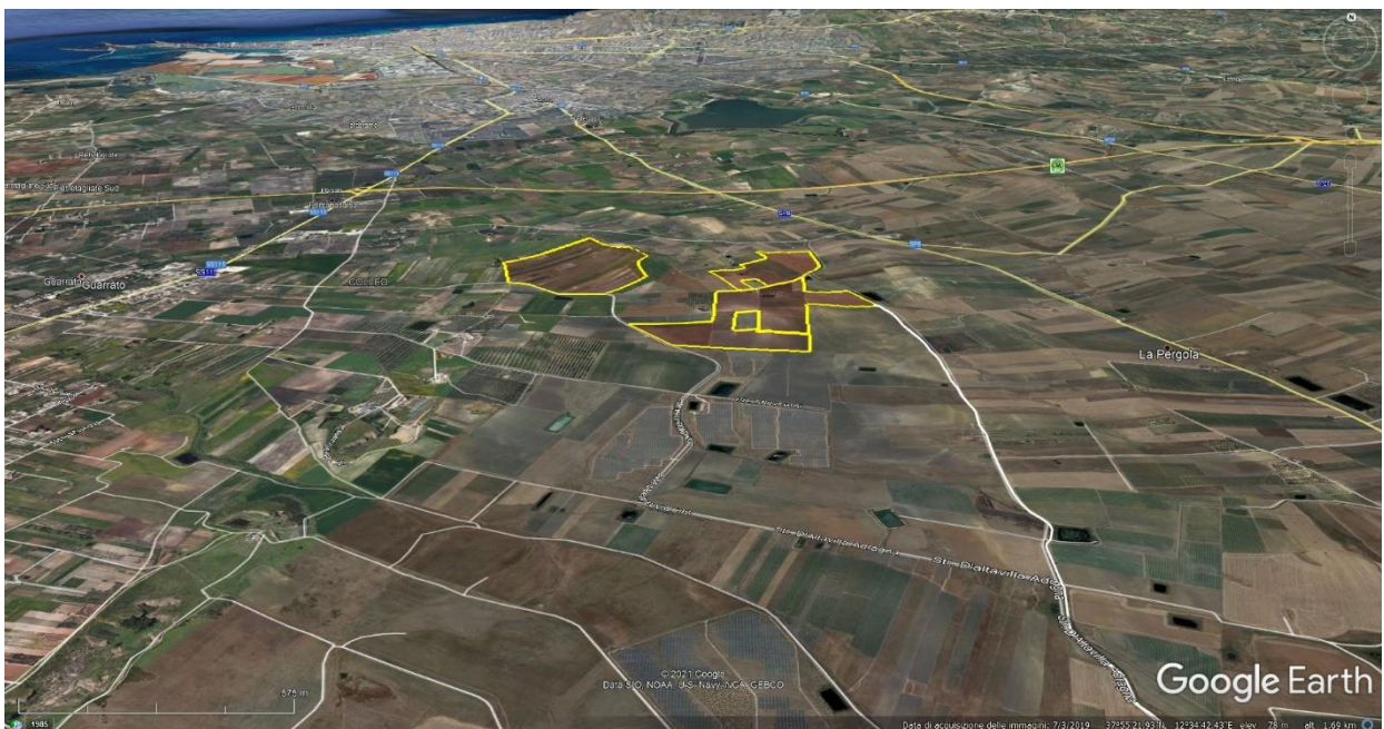
Figura 3_Vista a volo d’uccello are impianto FV “Guarrato”
