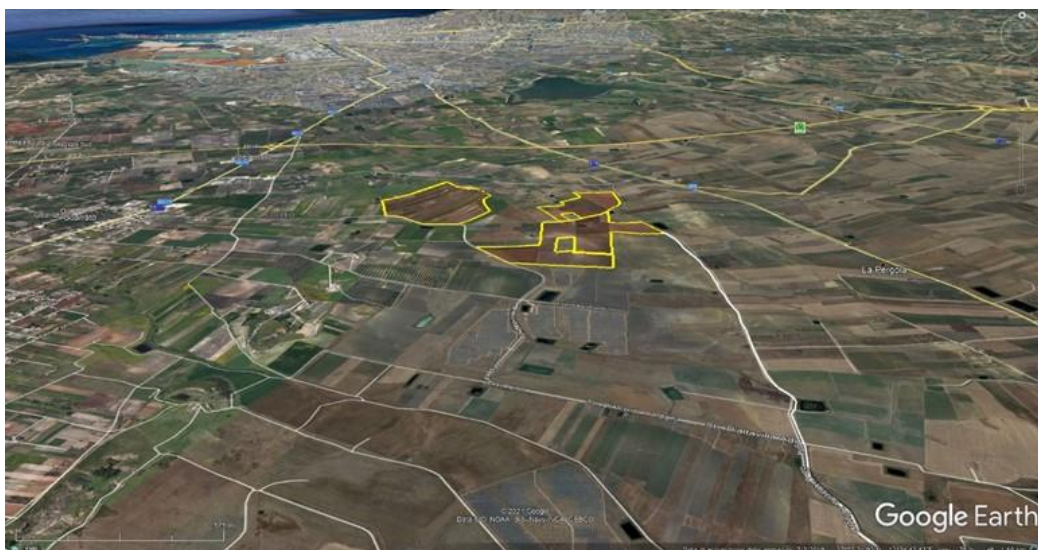
Fig. 3 - Vista a volo d’uccello are impianto FV “Guarrato”
