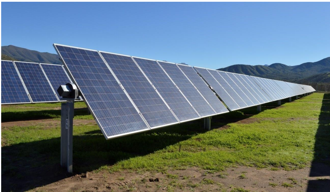
Vista qualitativa di tracker in configurazione 1V
