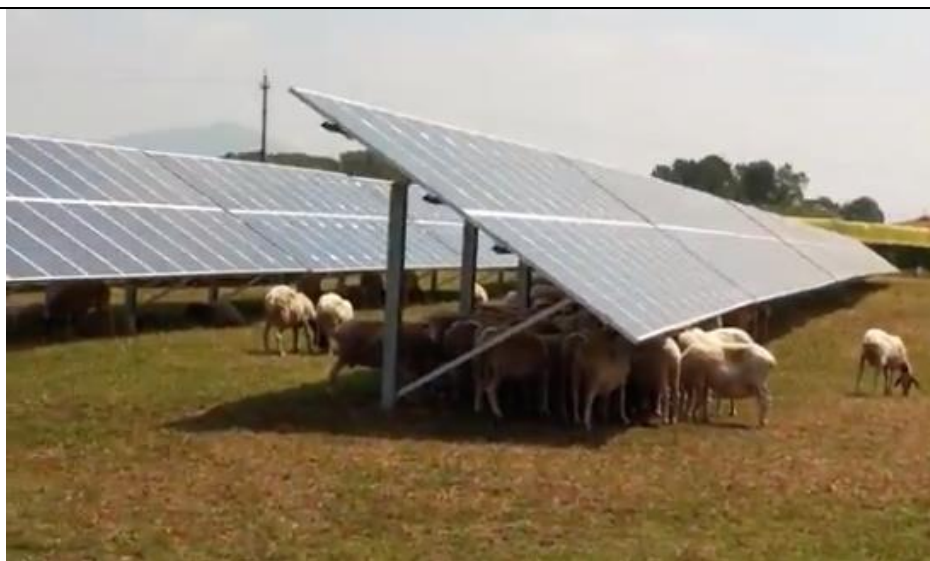
Figura 30 - Greggi di pecore come alternativa all'utilizzo di mezzi meccanici per il taglio dell'erba tra filari di moduli. Nella foto ripresa dal sito internet www.intellienergia.com , i sistemi di ancoraggio sono fissi, ma ovviamente nulla cambia nel caso di sistemi ad inseguimento.
