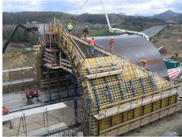
Figura 5 - Esempio di cassero per becco di flauto
