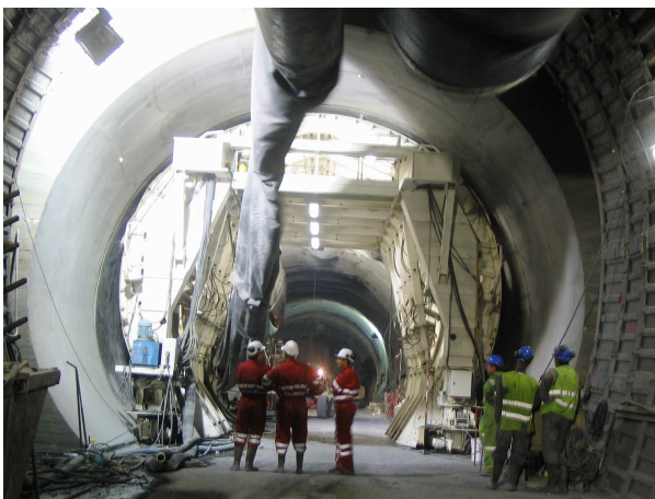
Figura 2 - Esempio di getto di calotta
