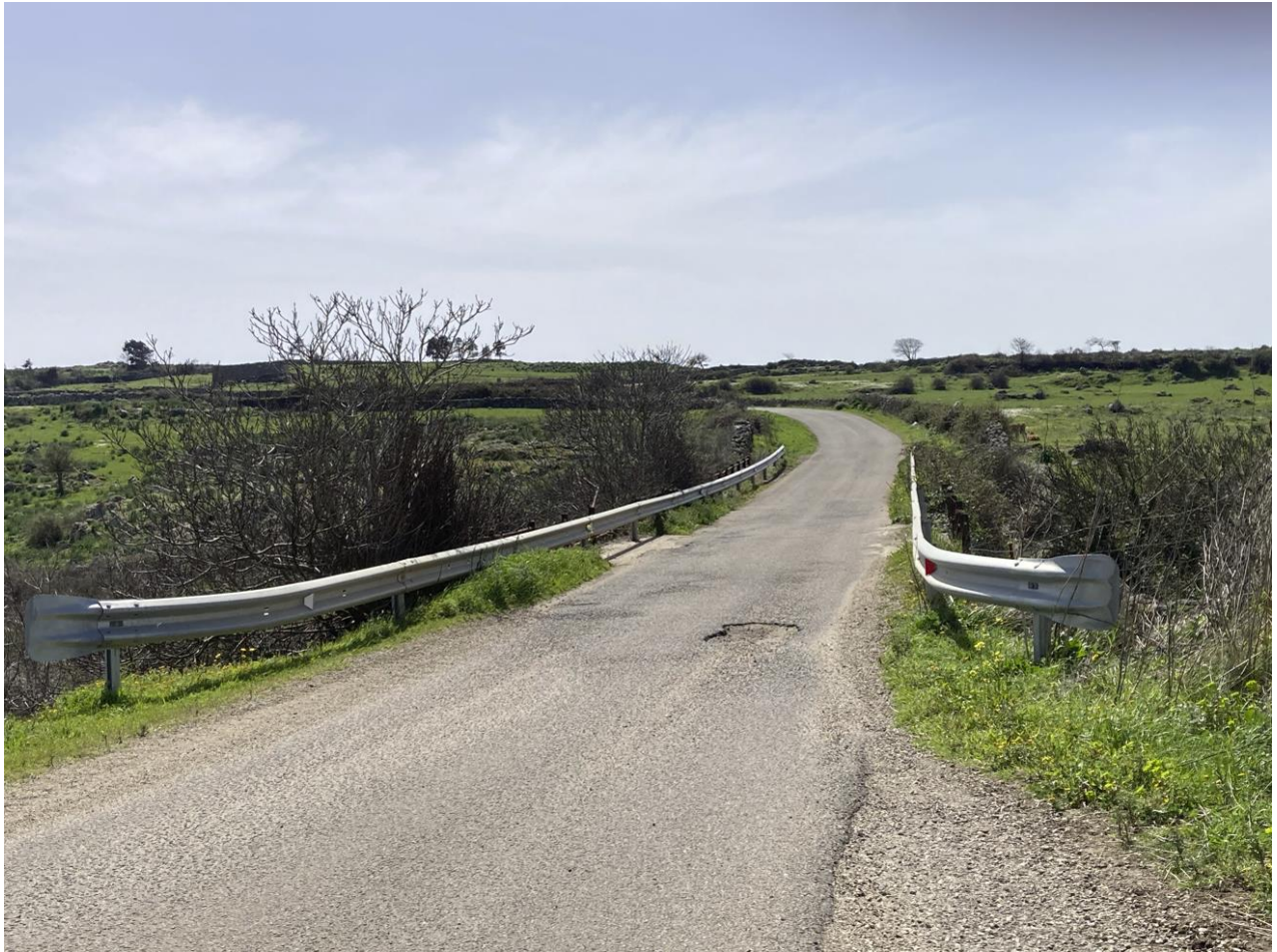
Figura 22. Foto da sopralluogo, opera di attraversamento in corrispondenza della viabilità esistente per il collegamento con la cabina raccolta e consegna (470053.11 m E, 4459079.16 m N)
