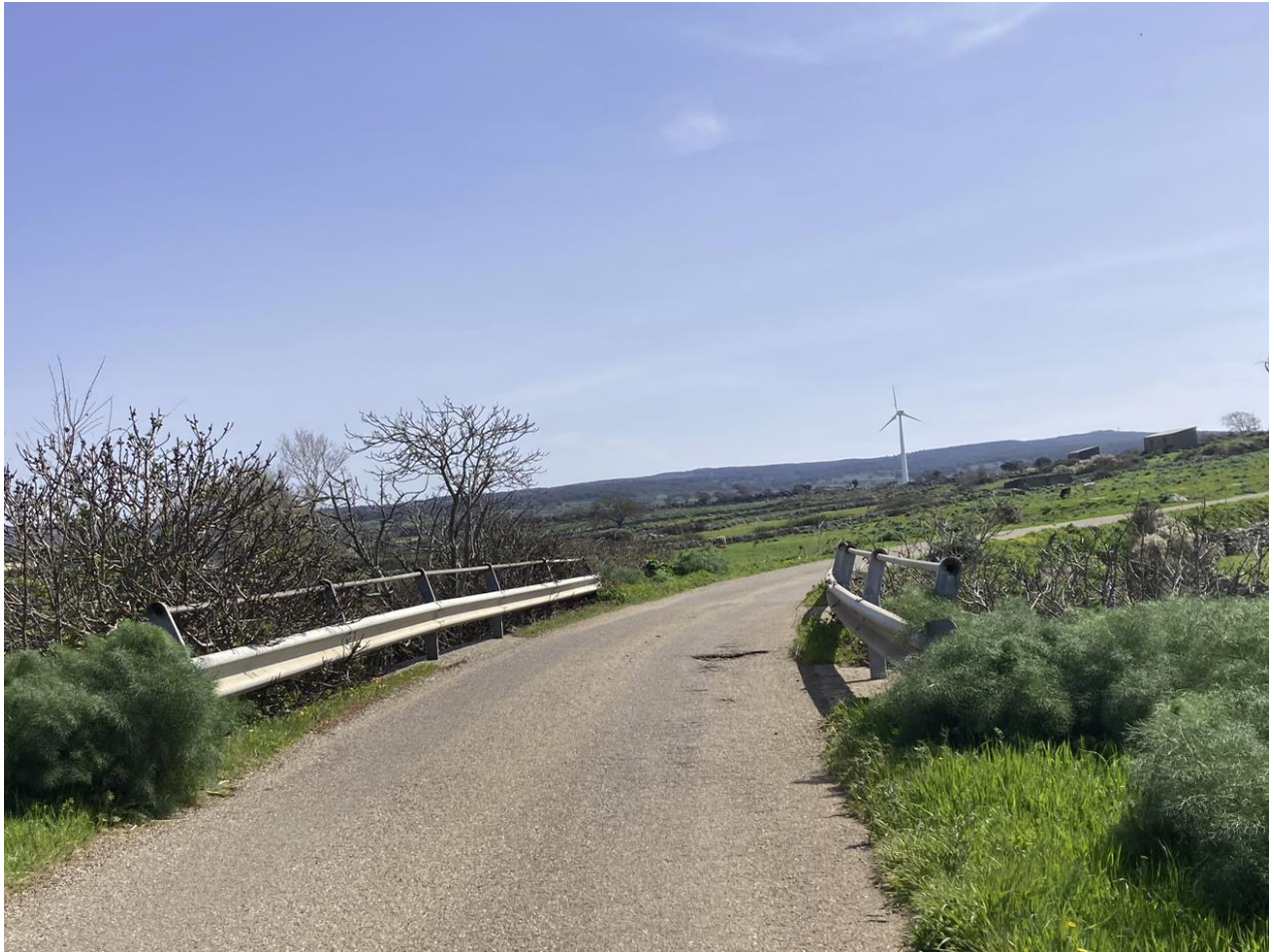
Figura 23. Foto da sopralluogo, opera di attraversamento in corrispondenza della viabilità esistente per il collegamento Cabina raccolta e cabina consegna (470383.43 m E, 4458534.56 m N).
