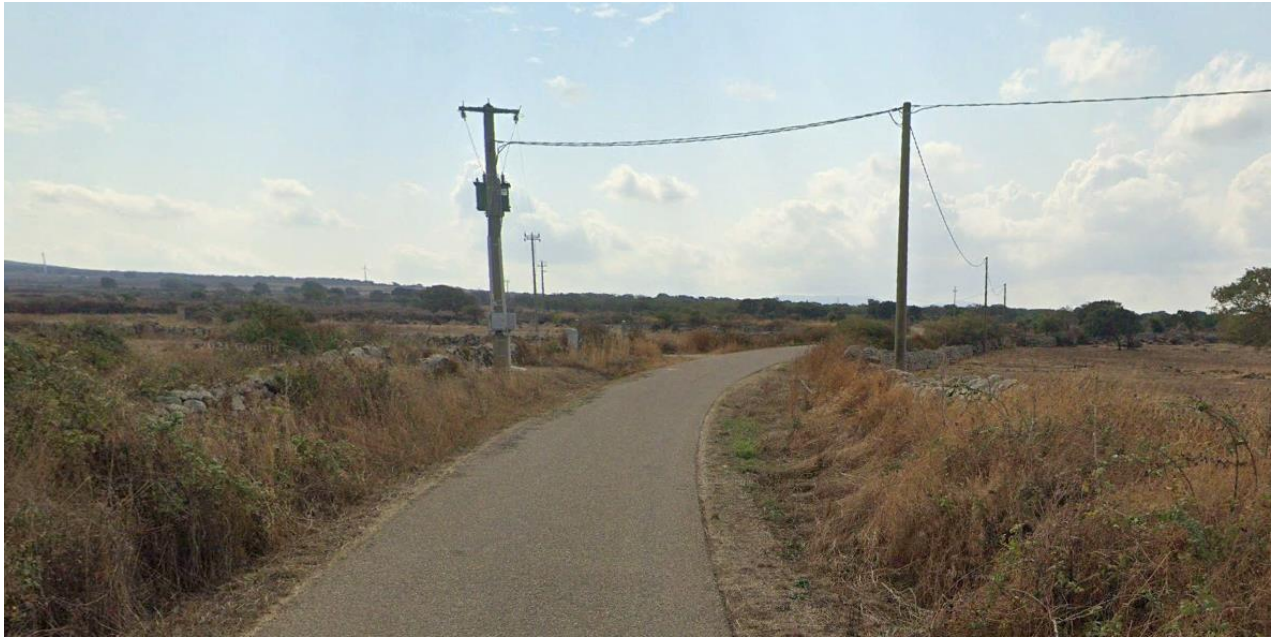
Figura 20. Foto da Google Earth attraversamento di linea elettrica MT lungo il tracciato di collegamento cabina raccolta e cabina consegna (470538.85 m E, 4458107.12 m N).
