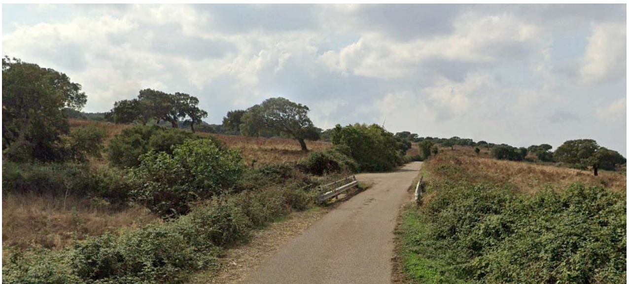
Figura 24. Fonte Google Earth opera di attraversamento in corrispondenza della viabilità esistente per il collegamento con la Cabina raccolta e consegna (471898.84 m E, 4456661.10 m N).
