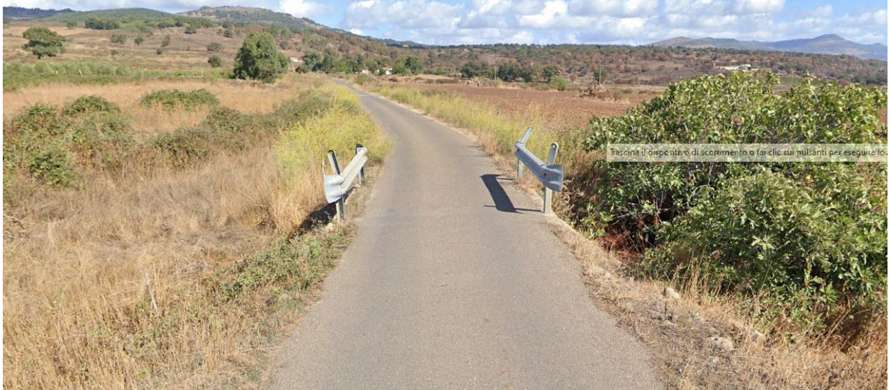
Figura 25. Fonte Google Earth opera di attraversamento in corrispondenza della viabilità esistente per il collegamento con la Cabina raccolta e consegna (478321.72 m E, 4453475.74 m N).
